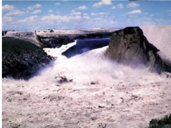
Figura 4. Rotura de la presa de Teton. Fuente: wikipedia.org
