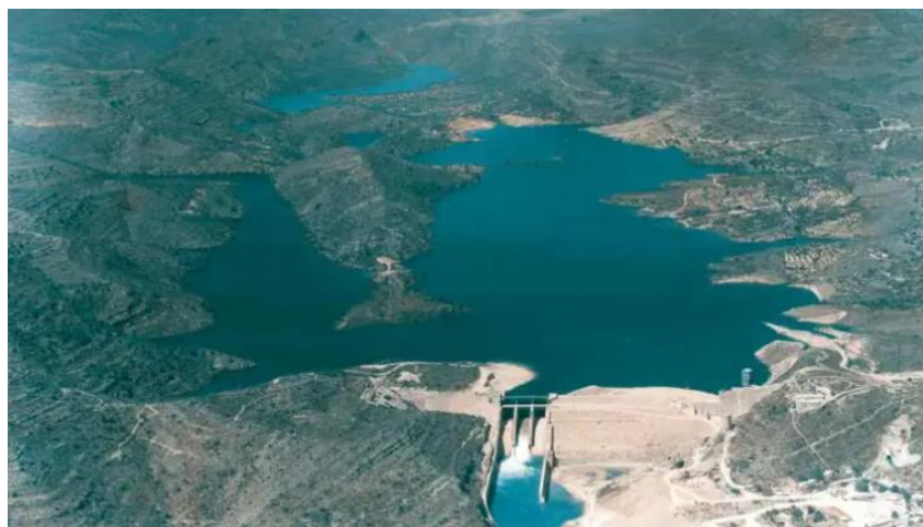
Figura 6. Antigua presa de Tous. Fuente: presamania.wordpress.com
