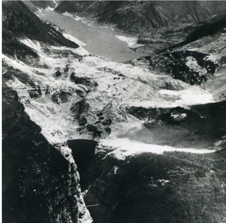
Figura 5. Estado del embalse de la presa de Vajont tras el derrumbe de las laderas. Fuente: victoryepes.blogs.upv.es
