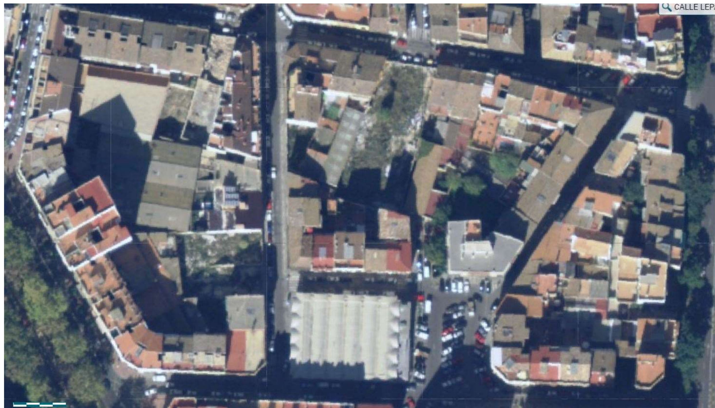
ZONA DE ACTUACIÓN AÑO 2010. DOMINADA POR EL TRÁFICO RODADO
