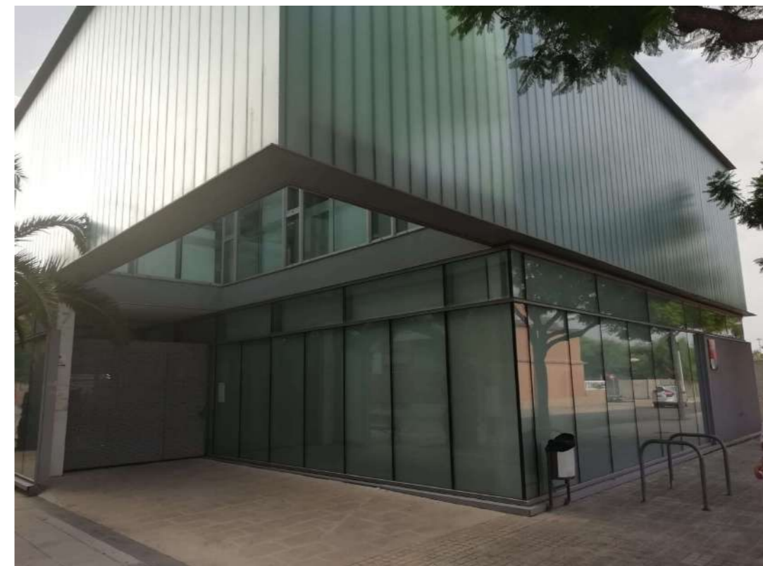
Vista exterior acceso Centro Labora de Manises
