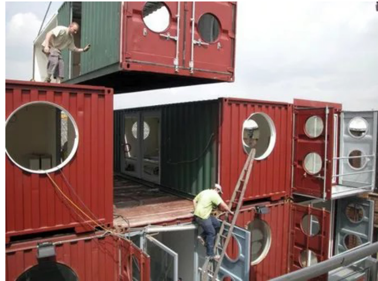
Figura 39. Container City, montaje de módulos.
