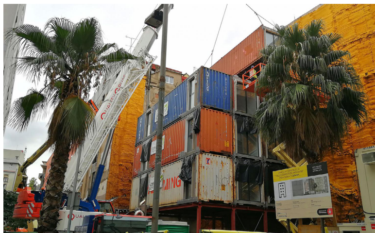
Figura 31. APROP Ciutat Vella en Barcelona, A. Goula, 2019. Nota. Edificio durante el montaje de los módulos de contenedores.
