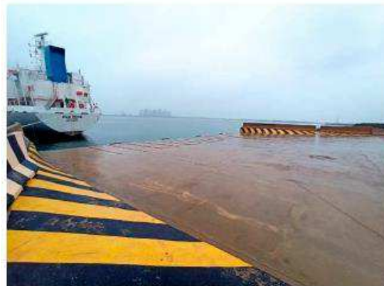
Vista general zona rampa Ro-Ro.
