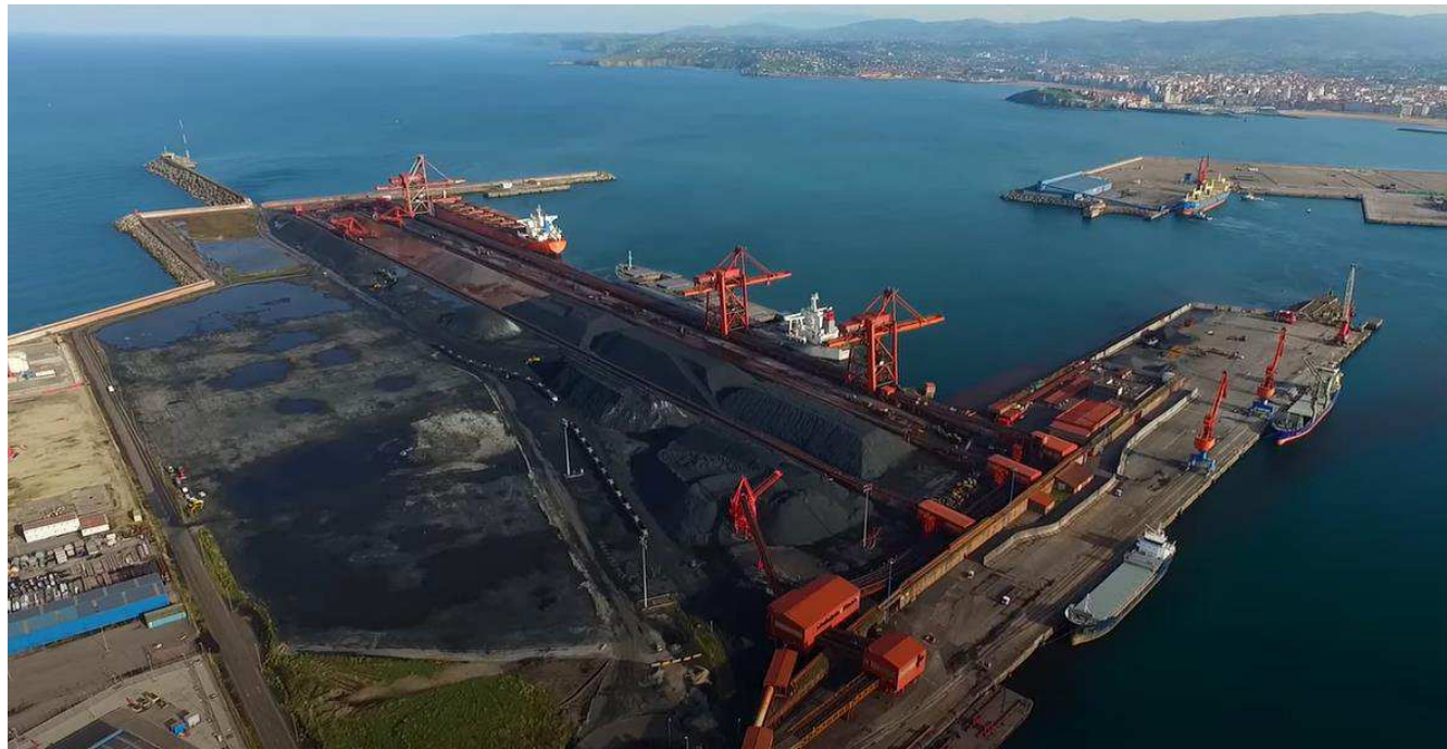
Ilustración 7. Terminal granelera EBHI (Musel). (Fuente: EBHI)
