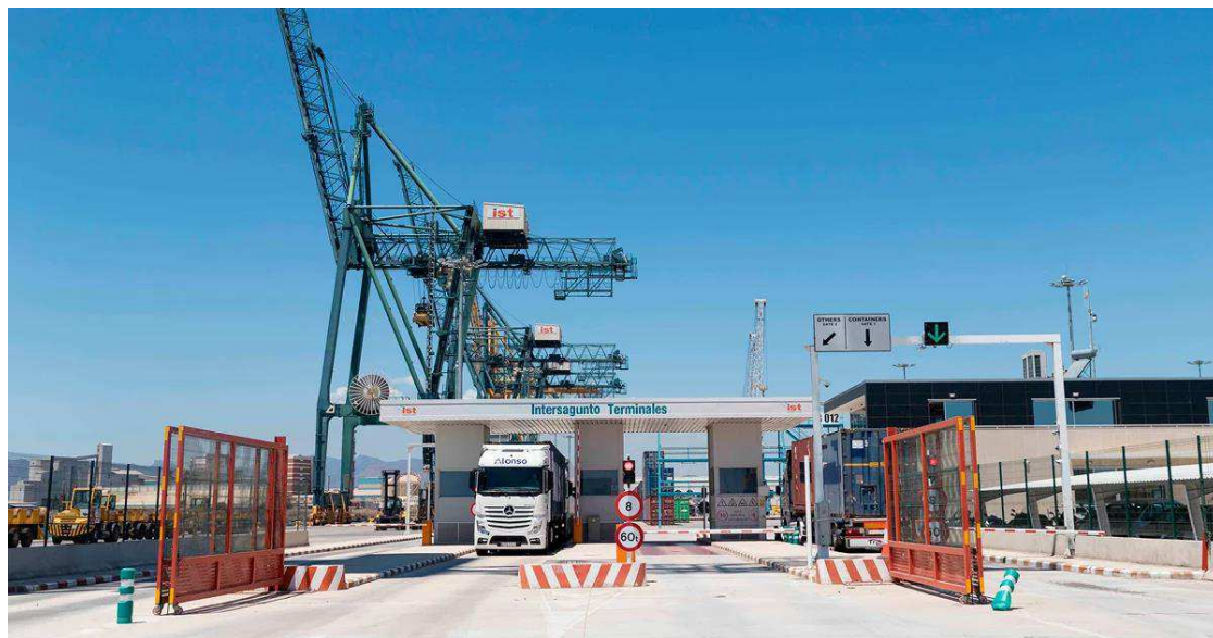
Ilustración 28. Puertas de acceso Terminal Intersagunto. (Fuente: Grupo Alonso)
