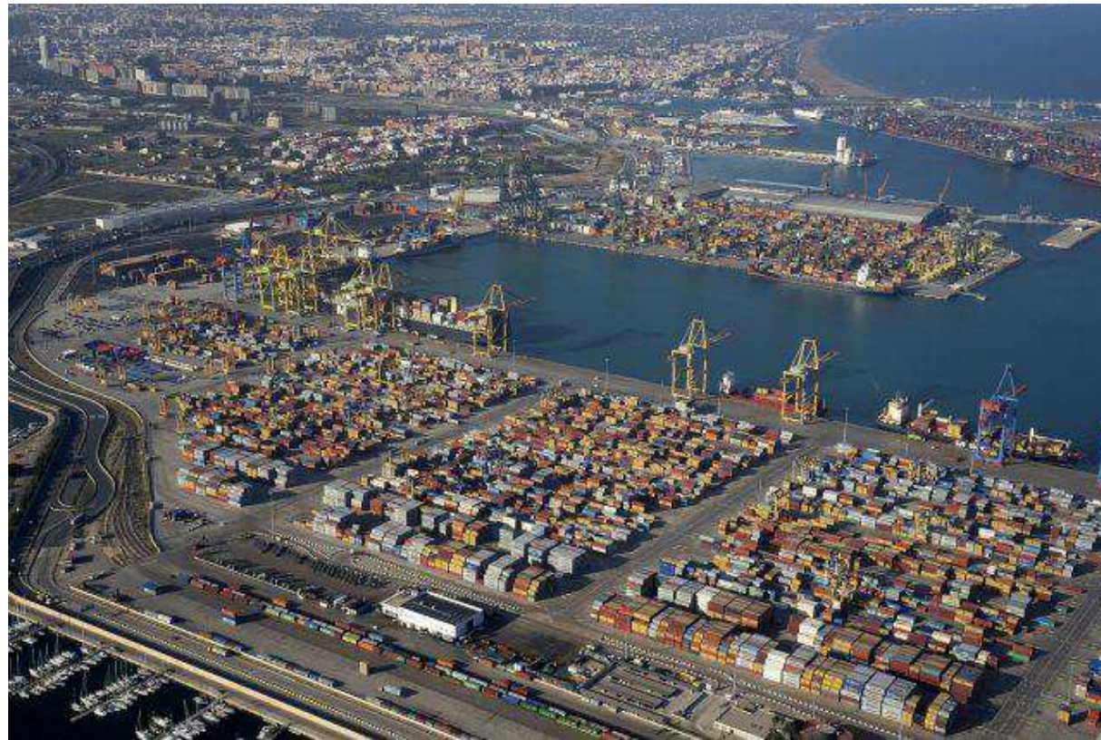
Ilustración 4. Terminal de contenedores CSP IBERIAN (Valencia). (Fuente:Valenciaport)
