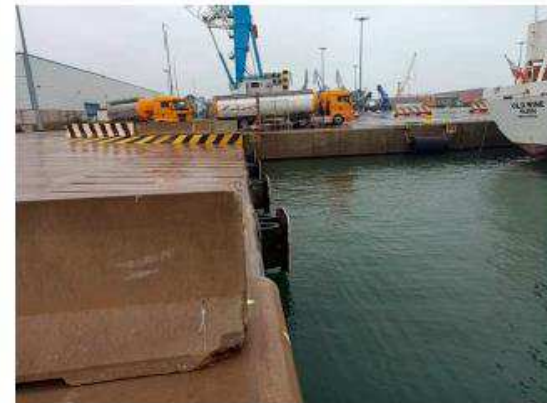
Defensas zona rampa Ro-Ro.
