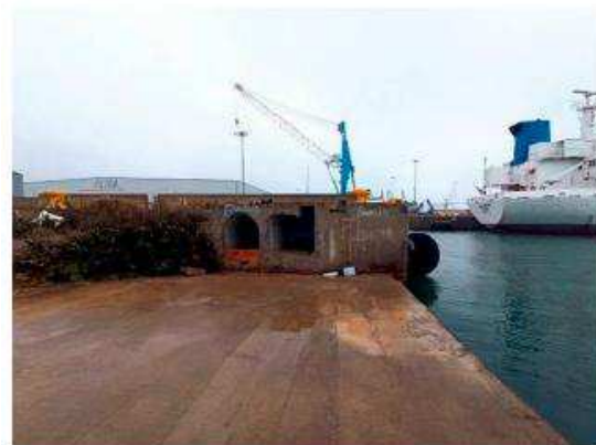
Zona norte del ámbito valorado, superestructura.
