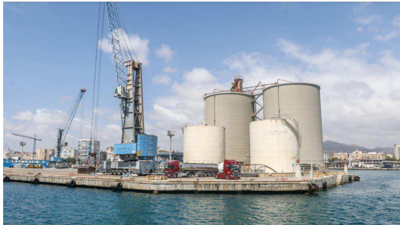
Ilustración 10. Terminal Opemar S.L, Puerto de Málaga. (Fuente: Vidaeconómica)
