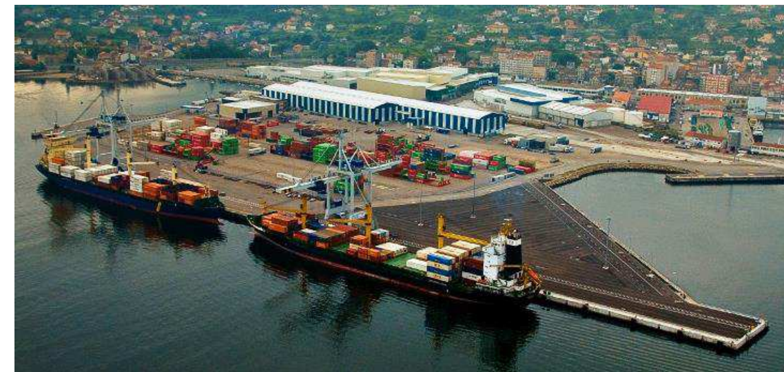
Ilustración 6. Terminal polivalente y de contenedores de Marín. (Fuente: PÉREZ TORRES MARÍTIMA)
