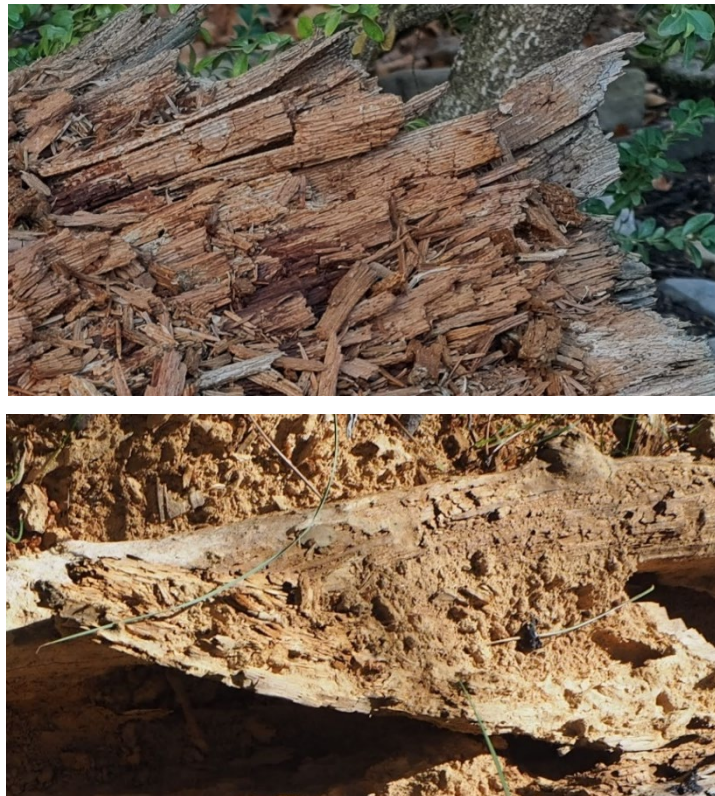
Figura 2. Distintas pudriciones de la madera. Arriba: pudrición parda. Abajo: pudrición blanca. En la pudrición parda, causada fundamentalmente por basidiomicetes, la celulosa y hemicelulosa se degradan rápidamente y queda la lignina. Como consecuencia, la estructura fibrosa de la madera se pierde y quedan residuos pardos en forma cúbica. La pudrición blanca se da por la acción de basidiomicetes y ascomicetes, y se degradan todos los componentes de la madera, incluida la lignina. Los residuos tienen un aspecto fibroso y blanco, debido a la oxidación y a la pérdida de lignina, de color pardo.
