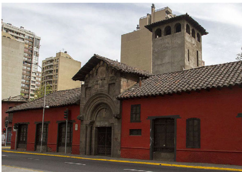
Fig. 1 Muros de adobe, Casona Quilapilún
