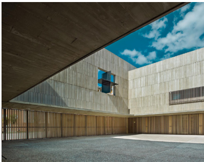
FIG 46. Cerramiento de hormigón. Fotografía: José Manuel Cutilillas
