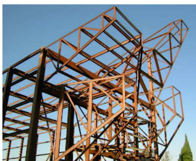
FIG 56. Estructura metálica de la cabecera de la iglesia. Fotografía: Ricardo Santonja
