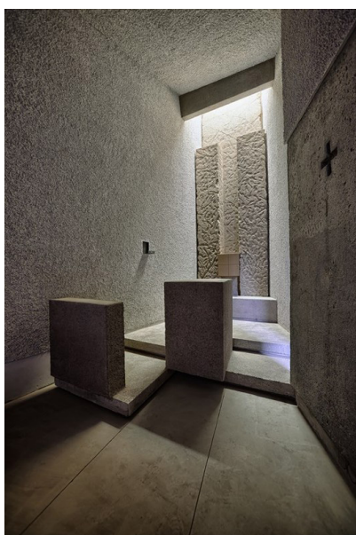
FIG 81. Focalización de la iluminación natural hacia la cabecera, con entradas de luz por el lucernario superior y la rasgadura lateral. Fotografía: Efraín Pintos
