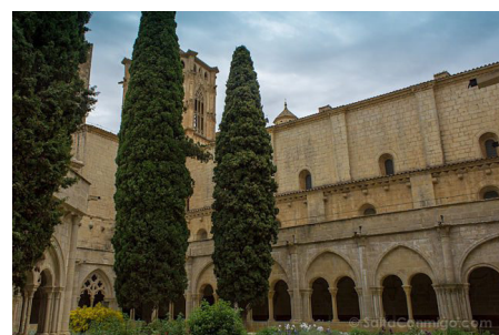
FIG 2. Claustro del Monasterio Cisterciense de Santa María de Poblet (Tarragona). Fotografía: JAAC.
