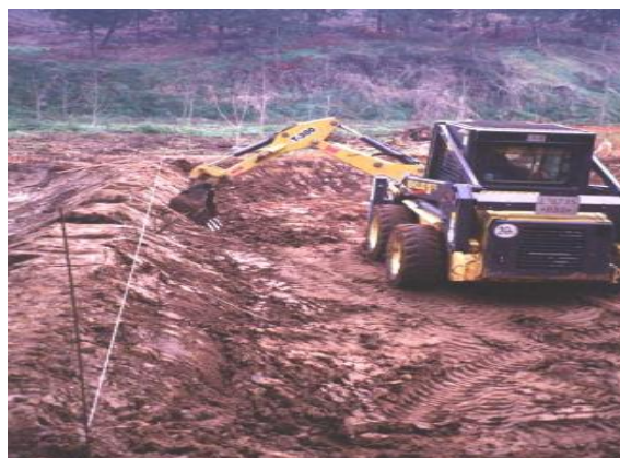
Figura 16. Excavación y conformación de taludes durante la construcción de un sistema de humedales construidos
