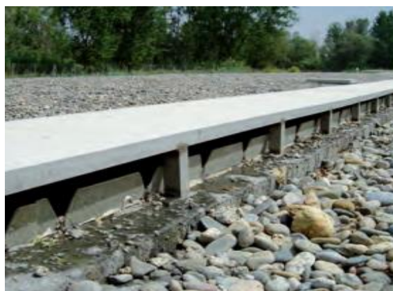
Figura 17. Excavación y conformación de taludes durante la construcción de un sistema de humedales construidos
