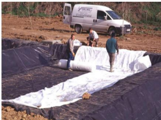
Figura 19. Operaciones de colocación del geotextil
