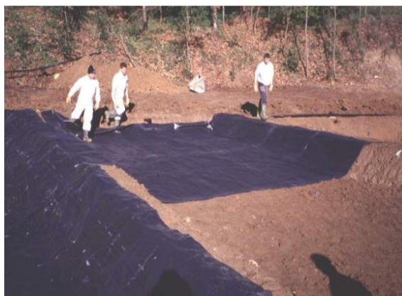
Figura 18. Operaciones de colocación de la geomembrana
