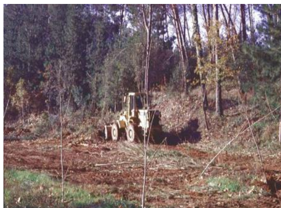
Figura 14. Operaciones de desbroce y limpieza durante la construcción de un sistema de humedales construidos
