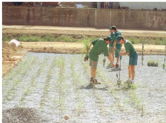
Figura 21. Operaciones de plantación de plántulas de carrizo en un sistema de flujo subsuperficial
