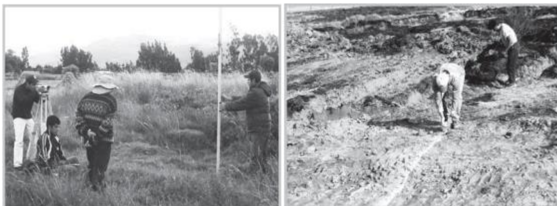
Figura 15. Levantamiento topográfico y replanteo
