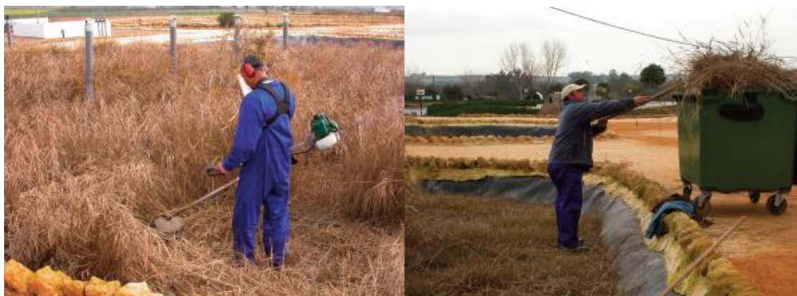
Figura 22. Siega mecanizada de la plantación de carrizo y evacuación de la biomasa seca tras la siega de un humedal
