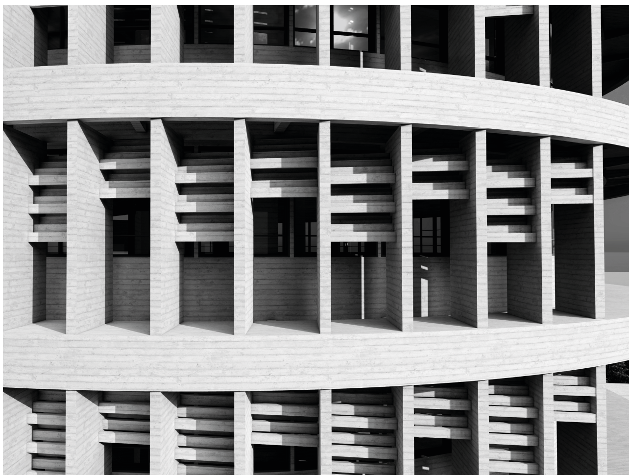
Fig.75. Elaboración propia de vista renderizada detalle de las protecciones a Sur de la torre central.
