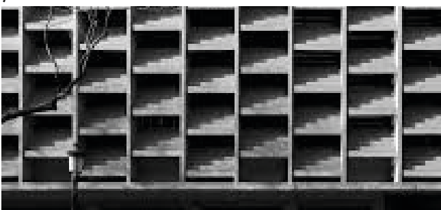
Fig.2. Fachada de la Facultad de Derecho de Valencia.
