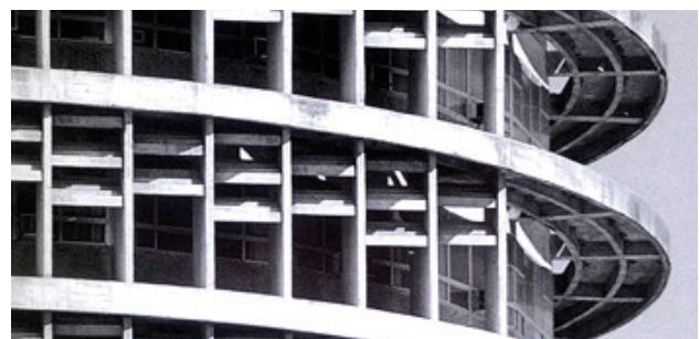
Fig.3. Fachada de la Escuela de Ingenieros Agrónomos, Córdoba.
