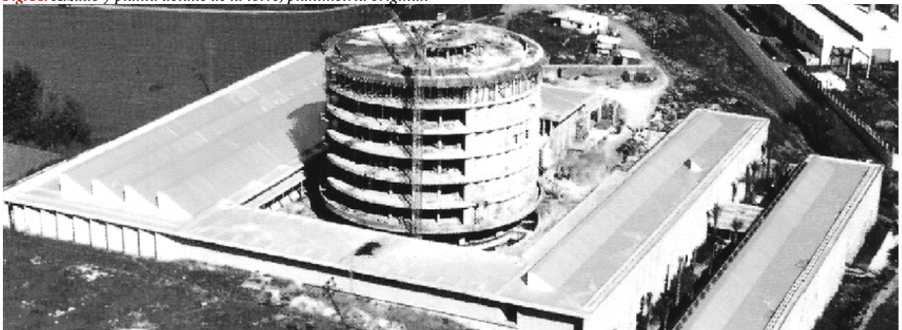
Fig.45. Vista del edificio en construcción.
