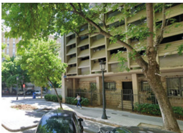
Fig.205. Facultad de Derecho. Fachada Este. Valencia.
