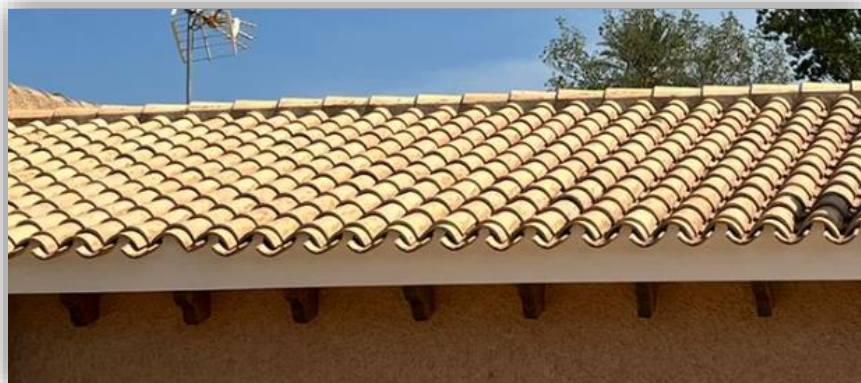
Figura 1.1.2.1-1. Cubierta objeto de nuestra instalación
