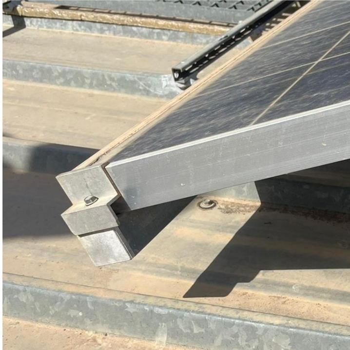
*Figura 23: Anclaje panel fotovoltaico. Fuente: Transelx S.L*
