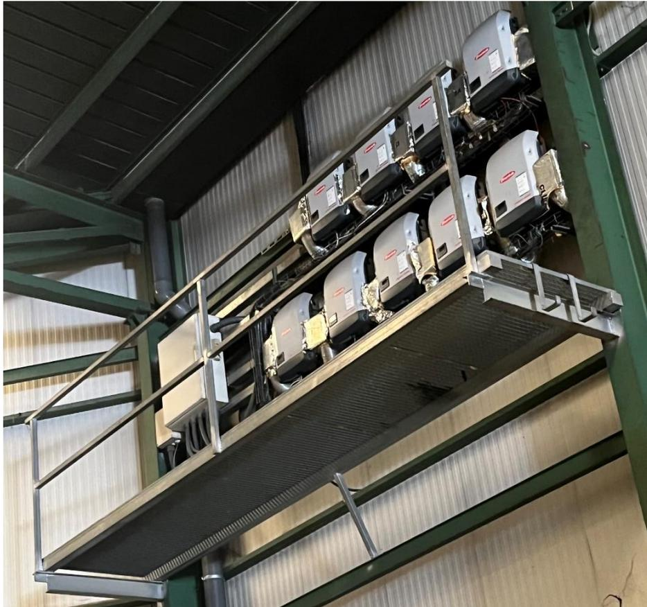
*Figura 25: Voladizo estructural para inversores. Fuente: Transelx S.L*
