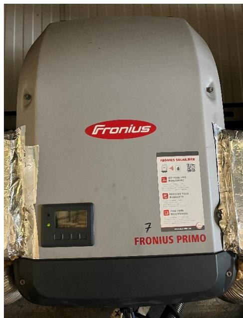
Figura 20: Inversor Fronius Primo 5.0-1. Fuente: Transelx S.L.
