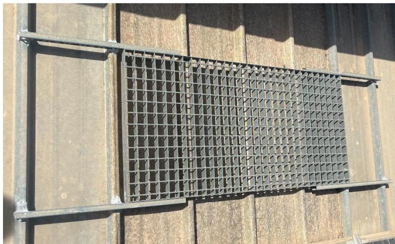
*Figura 24: Trámex de seguridad. Fuente: Transelx S.L*
