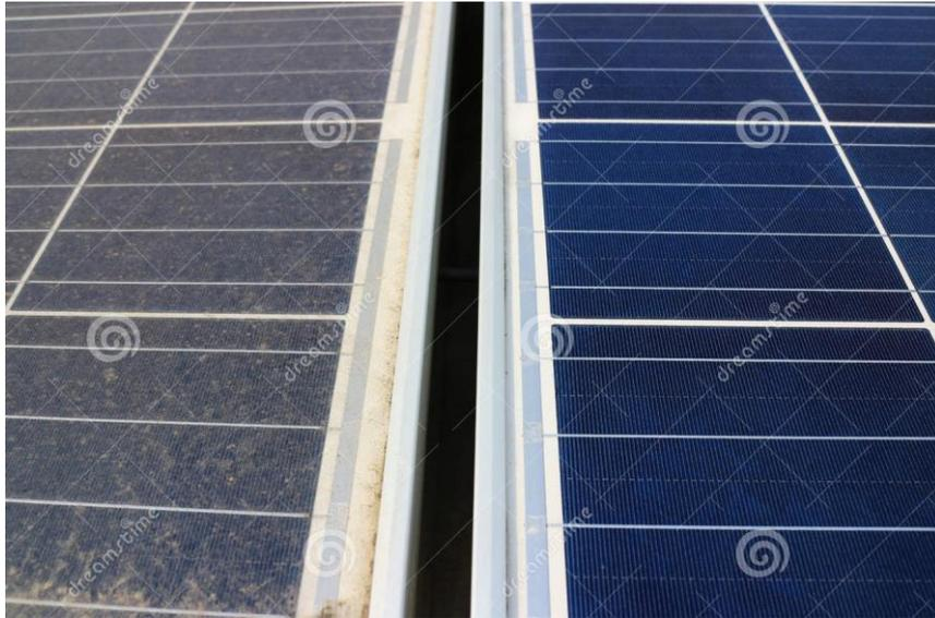
*Figura 29: Panel Fotovoltaico Sucio VS Limpio. Fuente: Autor*
