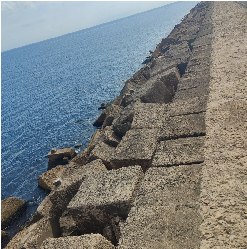
Imagen 12. Foto del tramo 3 del dique Norte. (Fuente: elaboración propia)
