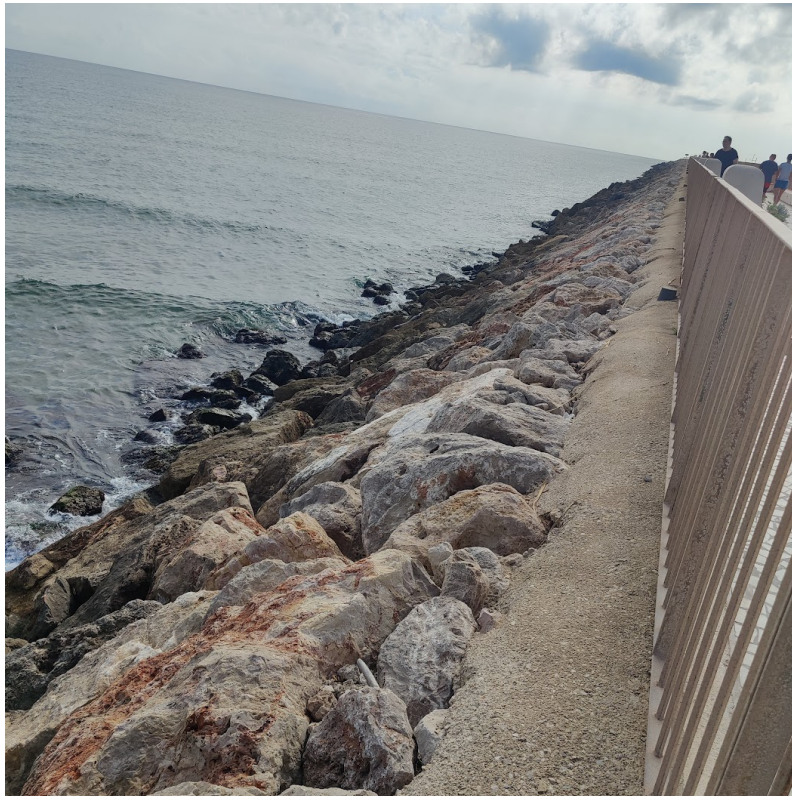
Imagen 10. Foto del tramo 2 del dique Norte. (Fuente: elaboración propia)
