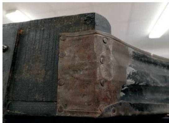
Figura 31. Vista detalle. Resultado final.
