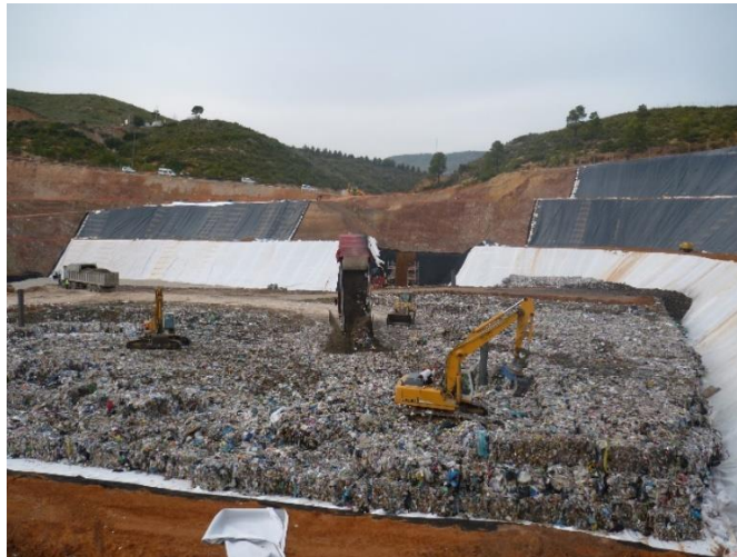
Figura 2. Vertedero anaerobio de Dos Aguas, Valencia. (EMTRE, 2023)
