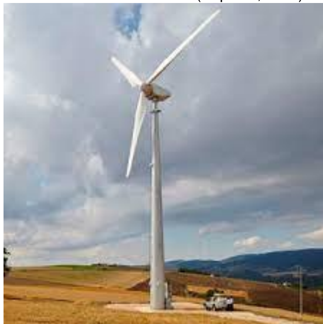
Ilustración 14: Aerogenerador de eje horizontal (Tozzi Green, s.f.)
