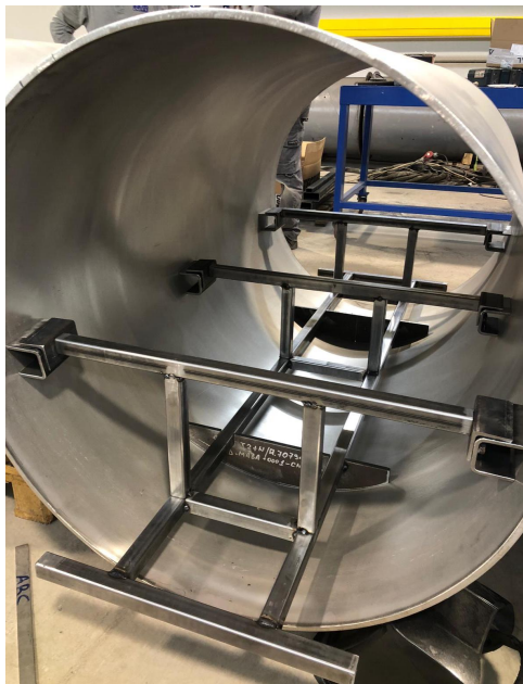
Figura 5.2: Soldadura interior tubería
