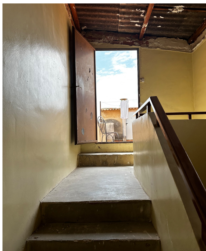
Figura 55: Estado inicial del espacio, escalera de entrada
