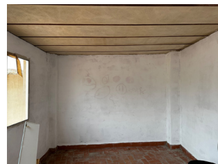
Figura 62: Estado inicial del espacio, almacén 04
