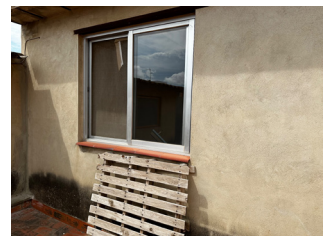
Figura 65: Estado inicial del espacio, ventana exterior 04
