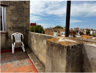
Figura 57: Estado inicial del espacio, muro terraza
