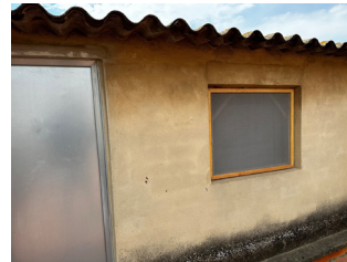
Figura 61: Estado inicial del espacio, ventana almacén 03
