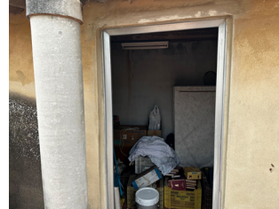
Figura 60: Estado inicial del espacio, entrada almacén 3
