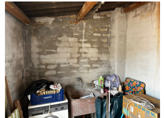
Figura 64: Estado inicial del espacio, fregadero almacén
