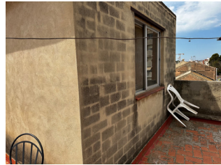
Figura 59: Estado inicial del espacio, ventana interior
