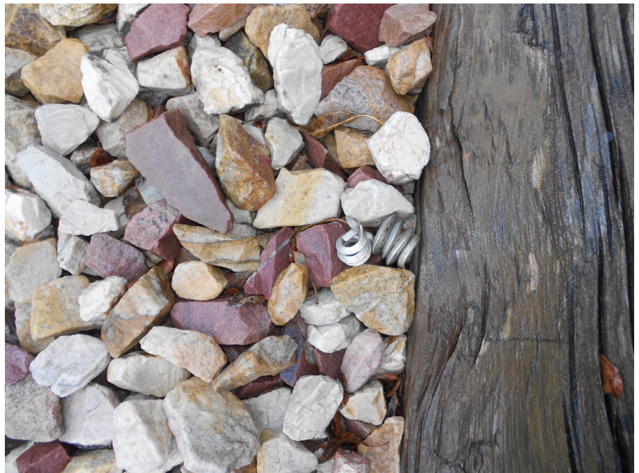
Fig. 8. Hierros en espiral. Posiblemente elemento que formaba parte de la estructura de la vía.
