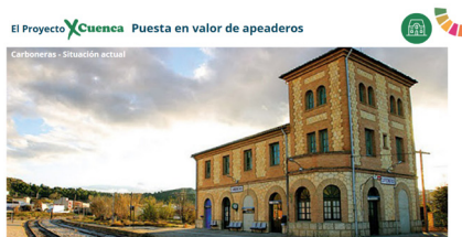
Fig. 39. Situación actual del apeadero de Carboneras.
