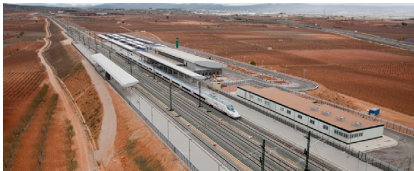
Fig. 31. Estación de AVE Requena-Utiel.
