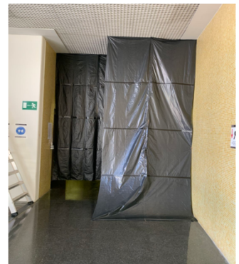
Por último se anclaron al techo de la entrada del pasillo los 2 paneles que servirían como puerta de entrada a la instalación.
