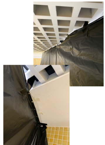
Se comenzaron a colocar los paneles en el espacio en las marcas previamente indicadas. Se anclaron al techo mediante chinchetas, bridas y cinta aislante, y posteriormente al suelo con cinta aislante.
