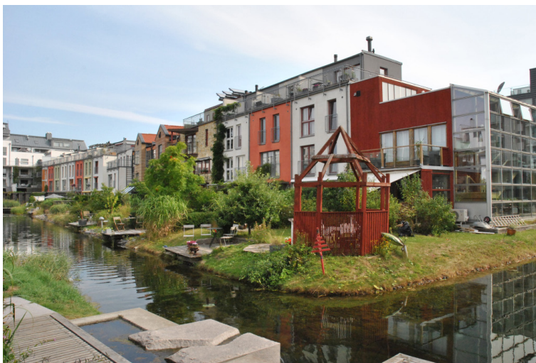
Figura 2.52. Sistema abierto de recogida de aguas pluviales en Augustenborg (Malmö, Suecia).
