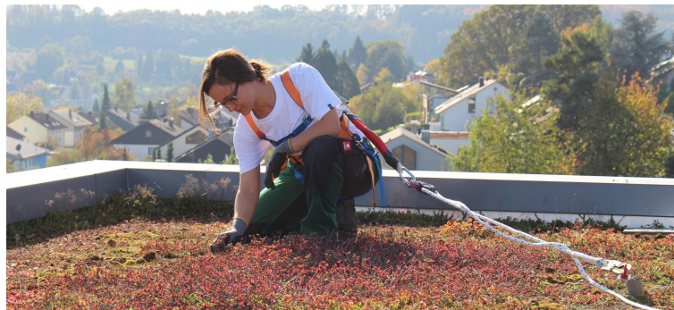
Figura 8.3. Punto de anclaje para EPIs de operarios de mantenimiento de la cubierta ajardinada.
