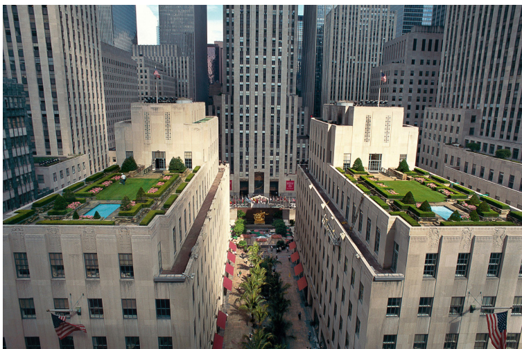
Figura 2.36. Cubiertas ajardinadas de los edificios bajos del Rockefeller Center (Nueva York, Estados Unidos).
