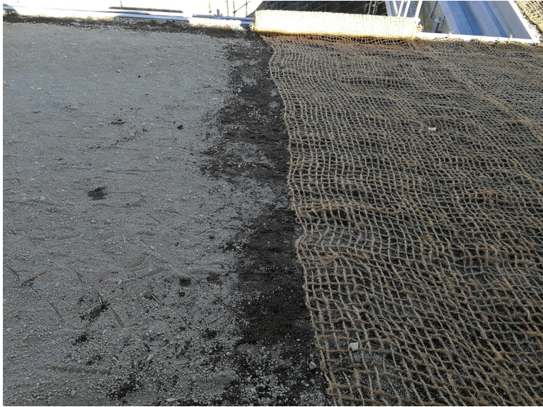
Figura 4.25. Control de la erosión superficial mediante el uso de malla de coco (dcha.).
