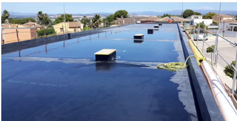
Figura 4.34. Prueba de estanqueidad una vez instaladas las láminas impermeables de EPDM.
