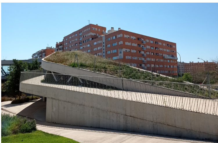
Figura 2.4. Vista de la cubierta ajardinada del Observatorio del Medio Ambiente Urbano, Alicante (España).
