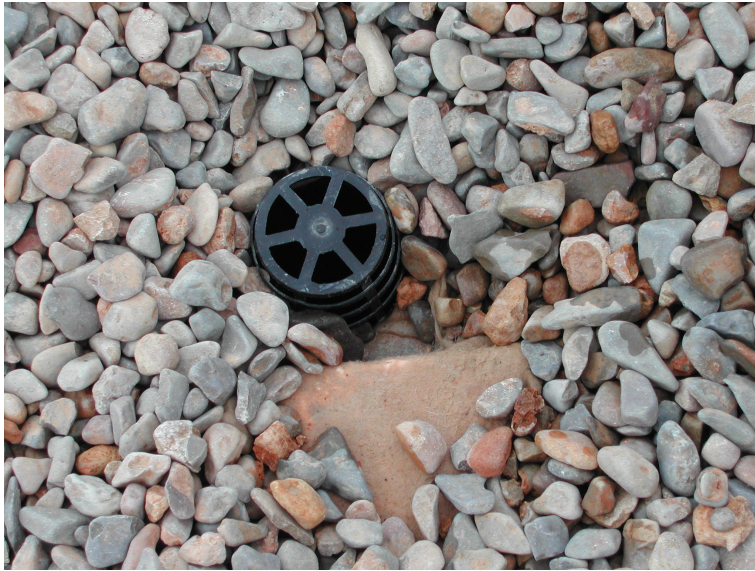
Figura 4.58. Zona de sumidero con paragravillas en cubierta de grava.
