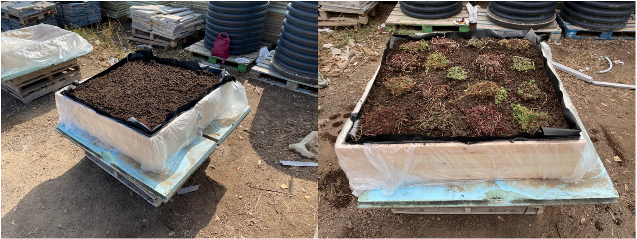
Figura 6.22. Instalación del sustrato (izq.) y de la vegetación con especies sedum (dcha.) en el modelo B.
