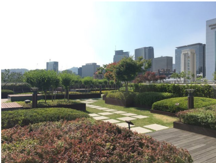
Figura 2.22. Cubierta ajardinada en la Seoul Library , Seúl (Corea del Sur).
