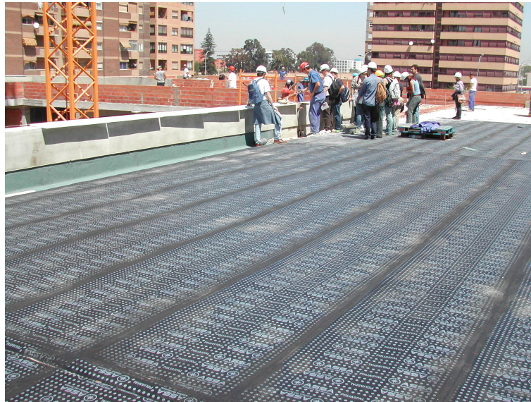
Figura 4.10. Impermeabilización de cubierta plana con rollos de LBM de 1 m de ancho.
