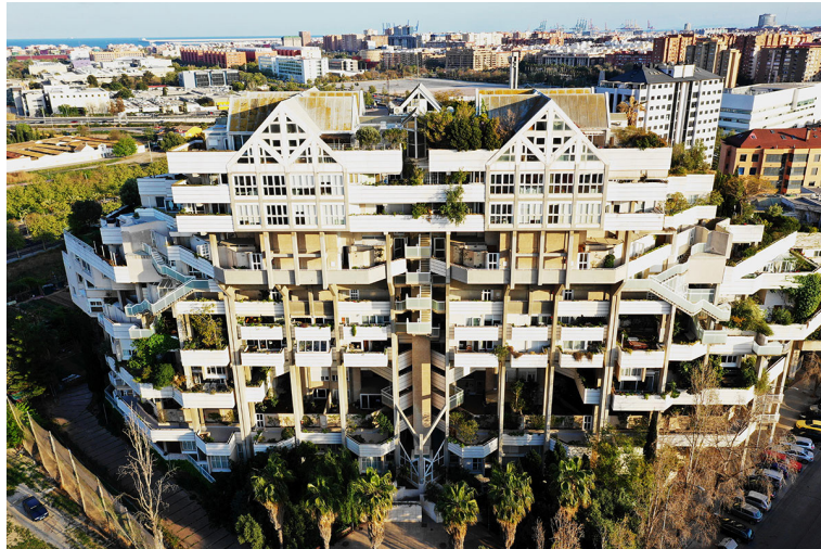
Figura 2.48. Terrazas ajardinadas a diferentes niveles en el edificio Espai Verd (València, España).
