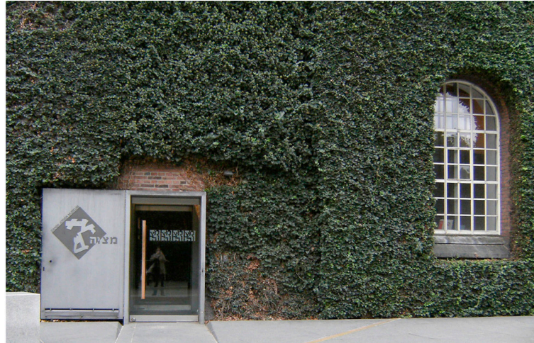
Figura 4.62. Fachada vegetal con sistema directo.
