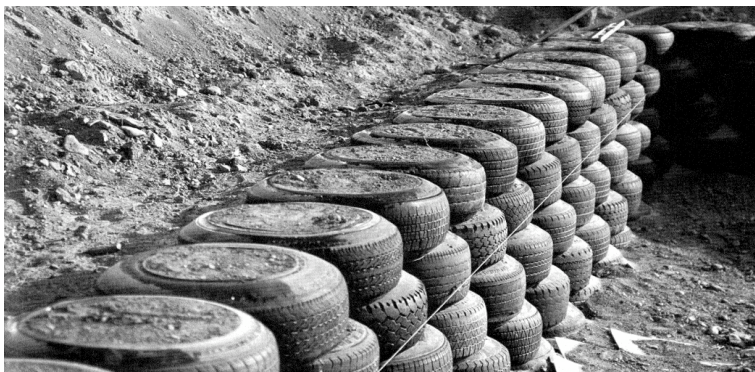
Figura 4.60. Muro de contención con ruedas de vehículo en desuso.
