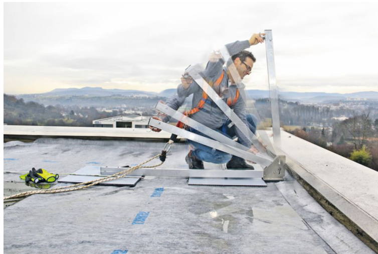
Figura 8.8. Montaje de la barandilla lastrada.
