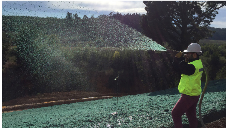
Figura 4.37. Instalación de vegetación mediante hidrosiembra.
