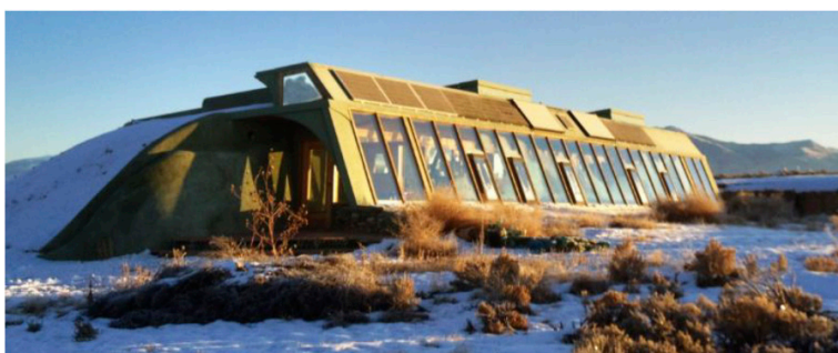
Figura 4.61. Vivienda Earthship en Taos, Nuevo México (Estados Unidos).
