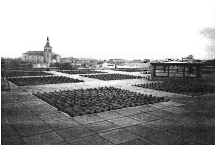
Figura 2.39. Cubierta aljibe y ajardinada del Ayuntamiento de Getafe (Madrid, España).
