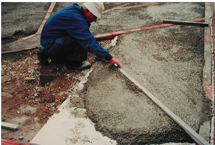
Figura 4.32. Relleno entre maestras de ladrillo para conformar la pendiente de la cubierta plana.
