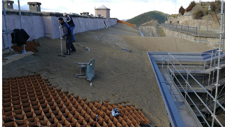
Figura 4.23. Protección del sustrato frente a la erosión mediante mallas tridimensionales.
