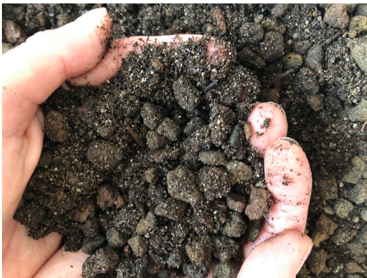
Figura 4.24. Composición de sustrato para cubierta ajardinada con materiales inorgánicos (cerámica y otros componentes minarles triturados) y orgánicos (compost vegetal y turba rubia).
