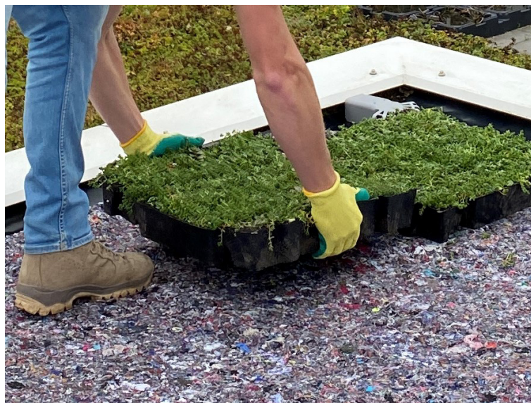
Figura 4.38. Instalación de vegetación mediante elementos o bandejas precultivadas.
