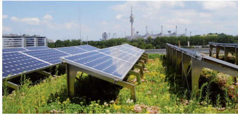
Figura 4.64. Cubierta ajardinada con paneles fotovoltaicos.
