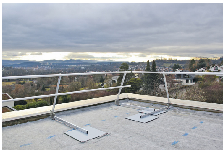
Figura 8.9. Montaje de la barandilla lastrada con ángulo de 67,5°.
