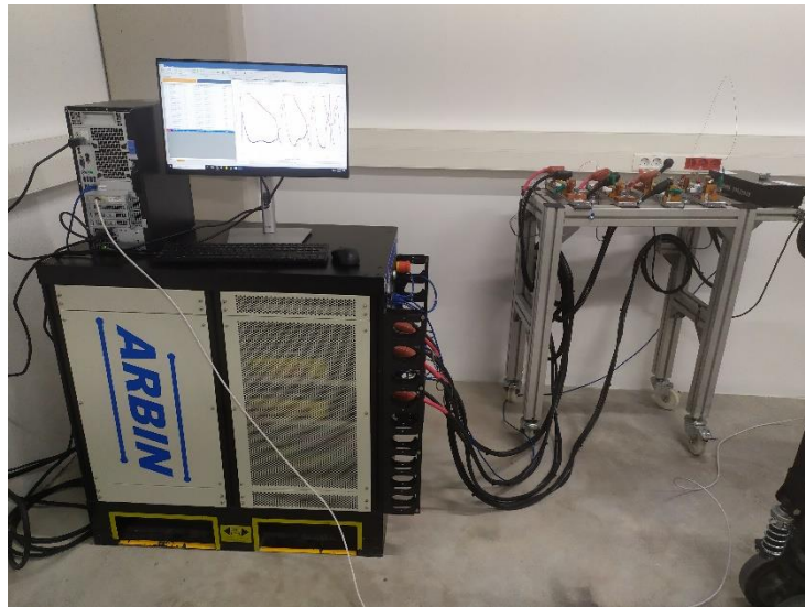
Ilustración 17. Montaje acondicionamiento celdas
