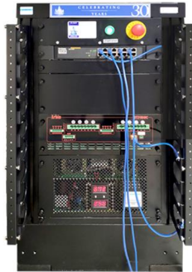
Ilustración 8. Fuente de alimentación LBT21084HC-5V-30a-8CH(12)
