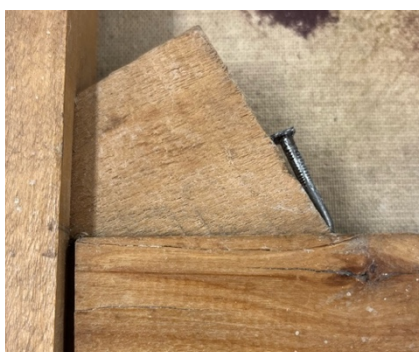
Fig. 48. Disgregación de madera adherida con Vinavil® 59.
