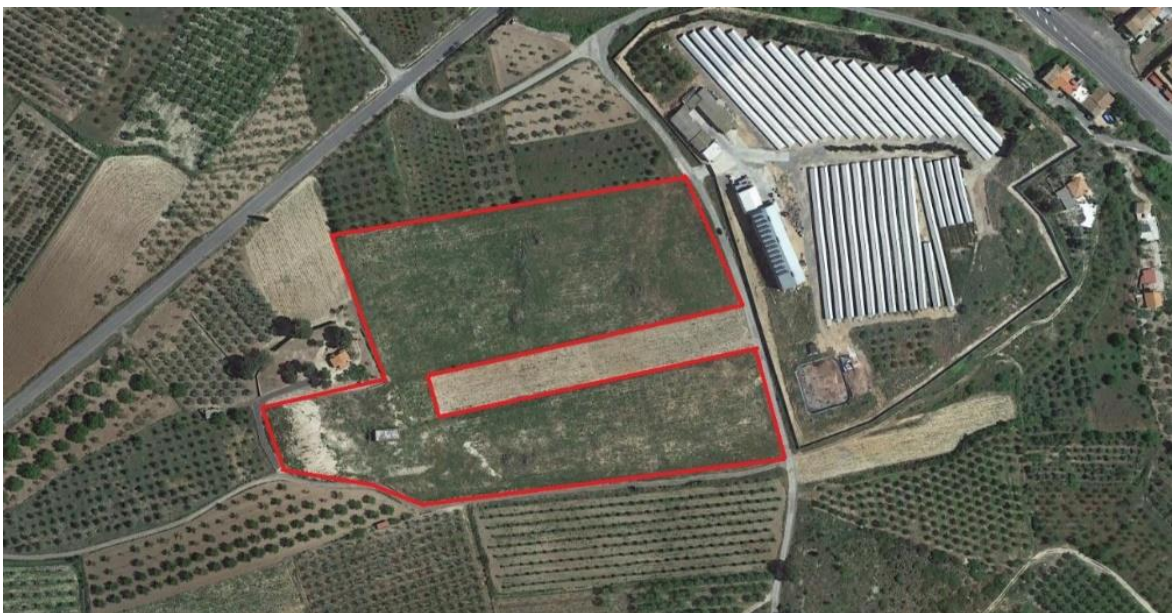
Imagen 1.3. Emplazamiento de la instalación fotovoltaica en Viver, Castellón [13]
