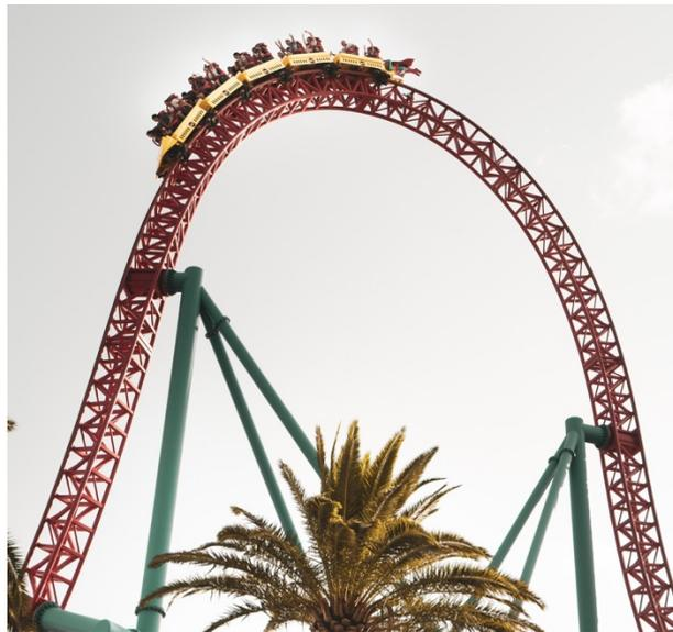
*Figura 28: Ejemplo de montaña rusa diseñada a partir de cuatro perfiles tubulares (Cercha tipo Warren)*
