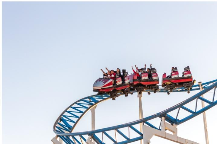
*Figura 26: Ejemplo de montaña rusa diseñada a partir de dos perfiles tubulares*
