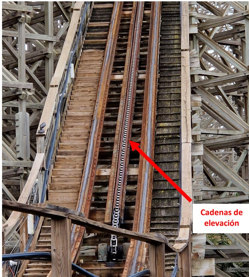
*Figura 13: Cadenas de elevación*
