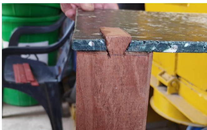
Figura 276. Encaje de cola de milano. [Fotografía]. Ferrando, L. (2023).
