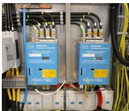
Figura 8. Controles de soldadura Harms & Wende
