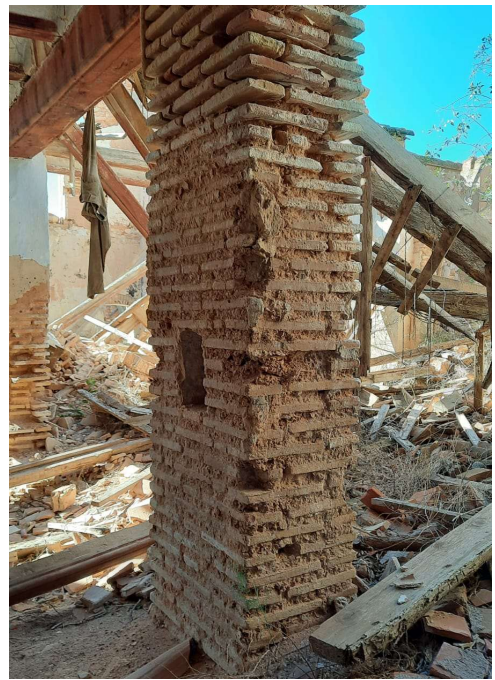
Figura 55: Pilar de ladrillo. Elaboración propia.
