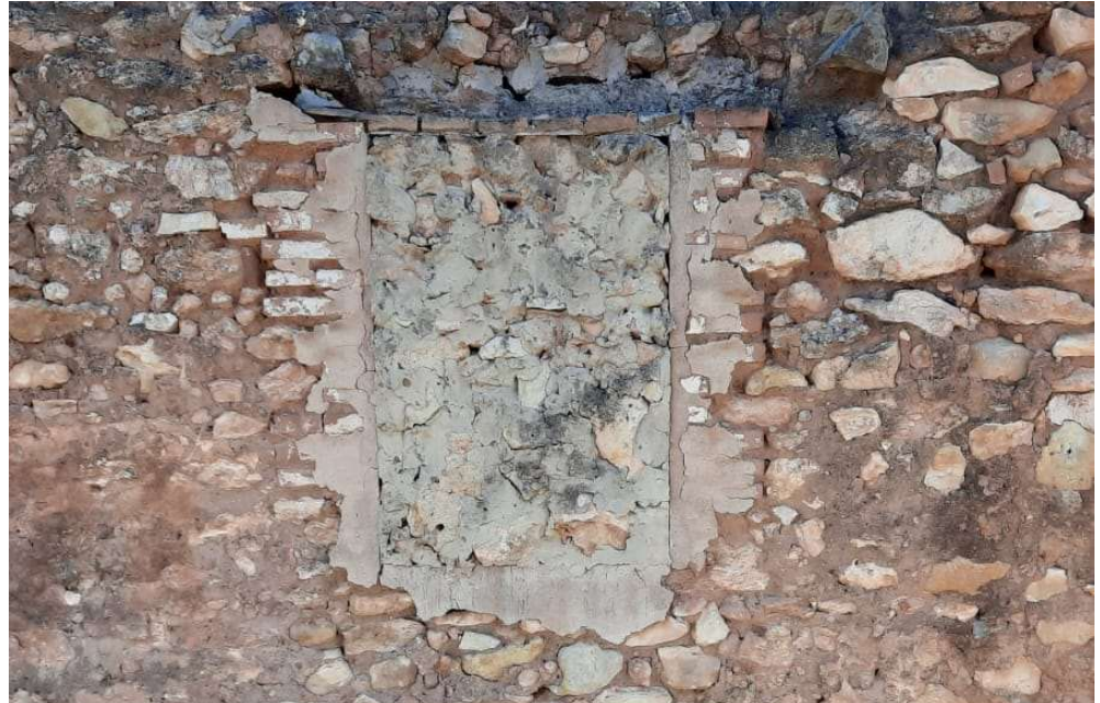
Figura 56: Detalle del uso de ladrillo en otros elementos como en las jambas de los huecos. Elaboración propia.
