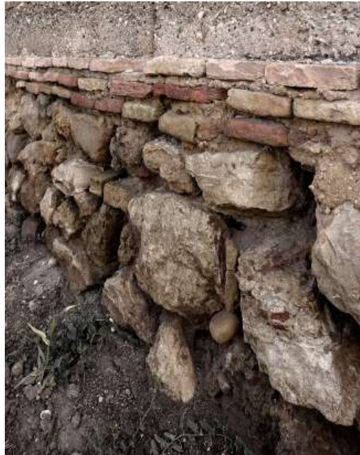
Figura 52: Imagen del arranque de un muro con cimentación de zapatas corridas con mampuestos. Fotografía no correspondiente a la Masía de la Almunia. Fuente: Pérez Vila.
