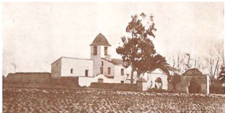
Figura 7: Alquería de El Magistre. Fuente: Alquerías de la Huerta Valenciana
