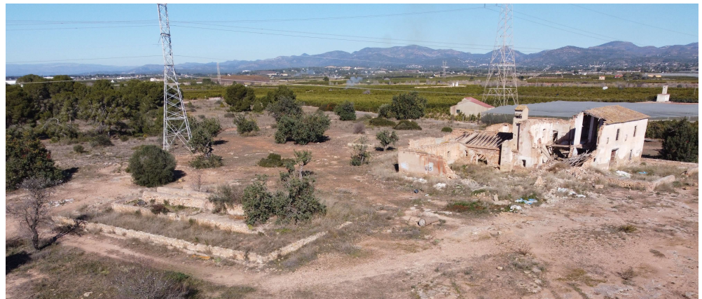
Figura 72: Fotografía del conjunto realizada durante el vuelo del dron, se aprecia la masía a la derecha y las balsas de esparto a la izquierda. Autor: Pablo Rodríguez-Navarro.
