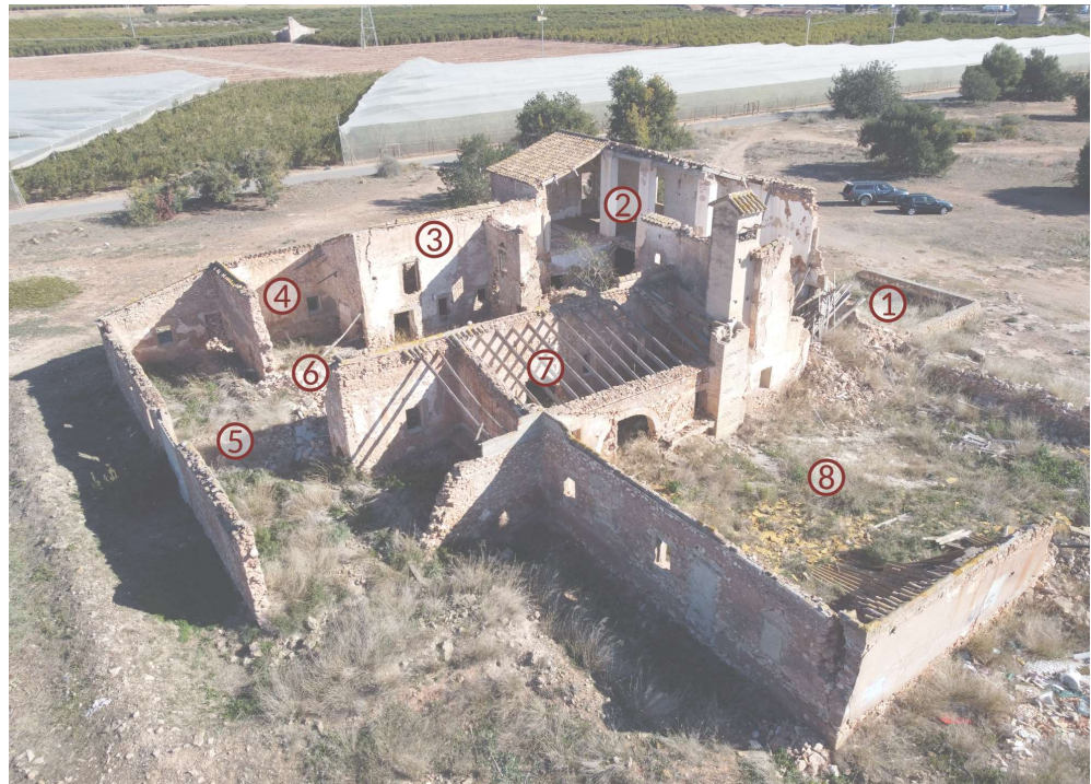
Figura 22: Imagen aérea mostrando los espacios de la Masía de la Almunia. Autor: Pablo Rodriguez-Navarro.
