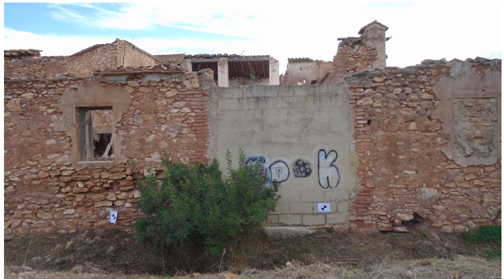
Figura 69: Tapiado con bloques de hormigón posterior. Elaboración propia.
