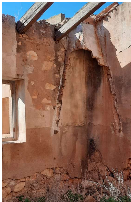
Figura 41: Huella de la chimenea dentro del volumen del riu rau, notándose los restos de ceniza en el paramento. Elaboración propia.
