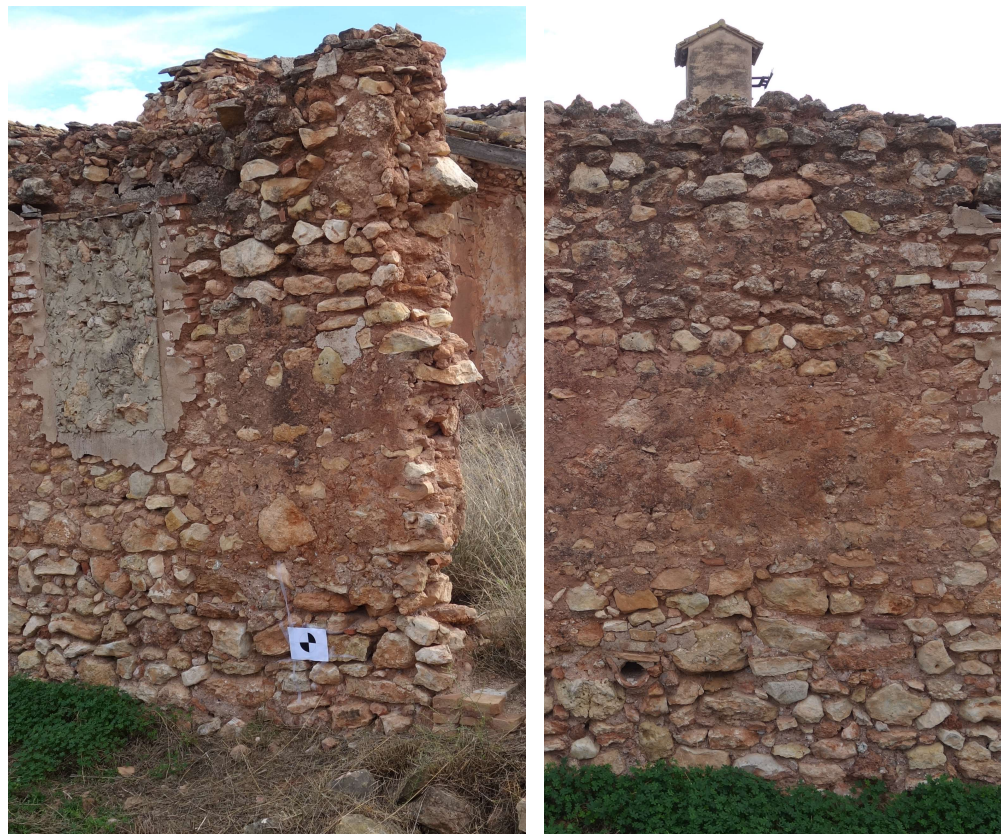
Figuras 57 y 58: Imágenes de muros exteriores de la Masía de la Almunia conformados con mampuestos. Elaboración propia.
