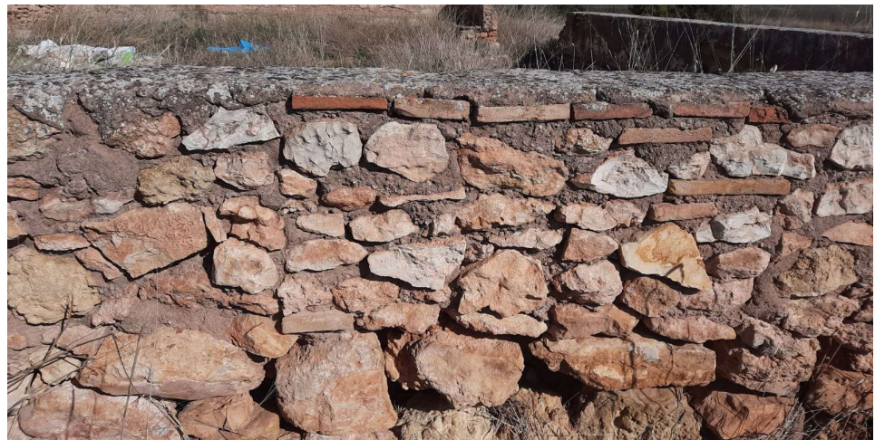
Figura 68: Detalle del murete de tapia valenciana donde se aprecian tanto los elementos de mampostería como las verdugadas de ladrillo. Elaboración propia.
