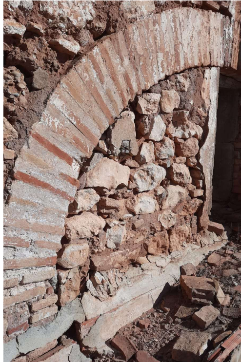
Figura 23: Arco cegado del riu rau. Elaboración propia.
