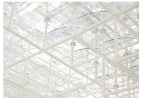
Figura 5.111 Discos transparentes de policarbonato
