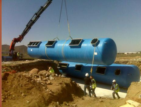
Depósitos horizontales para enterrar, fabricados en PRFV con los dos fondos toriesféricos y aros de refuerzo en PRFV.
