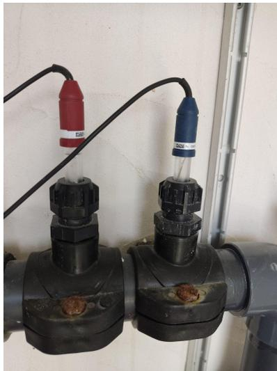
*Imagen 77. Sensores de PH y ORP instalados en tubería*
