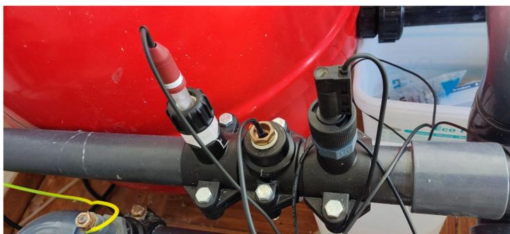
*Imagen 79. Sensores de PH, Vaina con sensor de temperatura del agua y flujostato*
