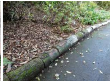
Figura 24. Troncos de podas como elemento estructural.
