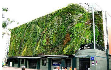
Figura 13. Fachada verde con la técnica de Patrick
