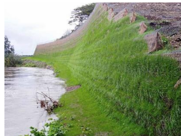
Figura 26. Muro de gaviones con vegetación.
