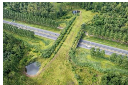
Figura 30. Paso de fauna en carretera en North-Brabant, Países Bajos.
