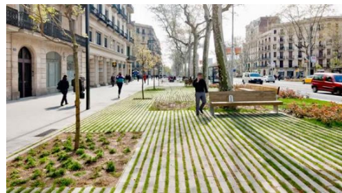
Figura 16. Pavimento permeable (SUDS) en Barcelona.
