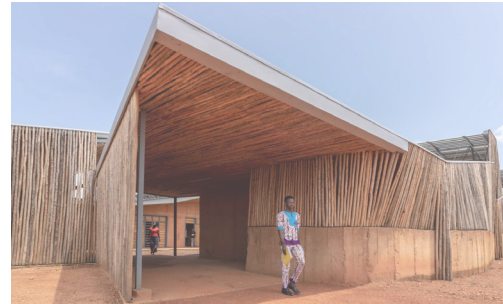
Figura 56: Escuela Secundaria Schorge, Kéré
