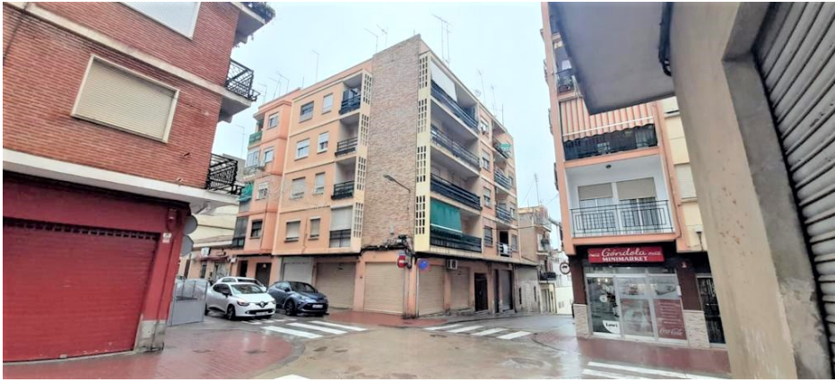
Fotografía de la fachada principal
