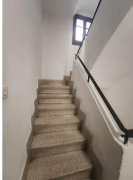
Imagen 7. Tramo de escalera. (Imagen propia, 2023).
