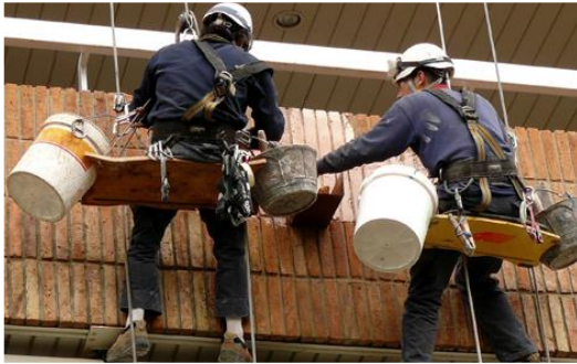
Imagen 33. Trabajos verticales en altura. (Google, 2023).
