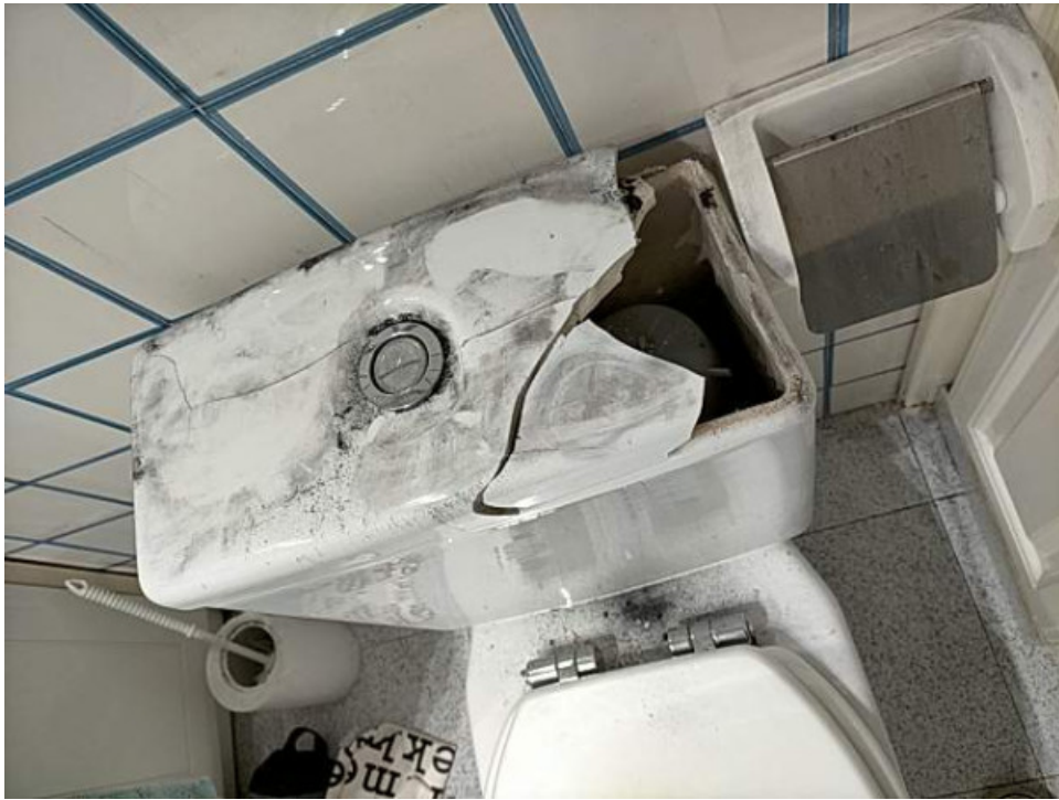
Desperfectos en cisterna
