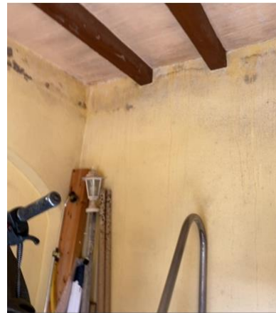
Imagen 19 cubierta en mal estado/Fuente propia
