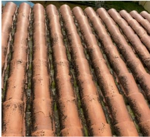
Imagen 19 cubierta en mal estado/Fuente propia
