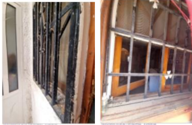
Imagen 29: Ventana con rejas/fuente propia
