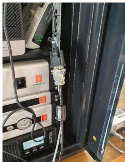
Figura 27 Conexión del perfilador al rack para la carga de datos Fuente: Propia
