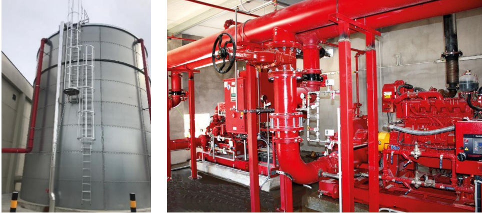
Ilustración 4. Izquierda depósito de agua y derecha sistema de bombeo. (Tankeros) (RevistaUNE)
