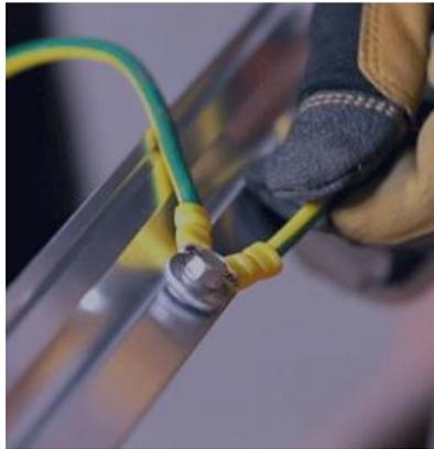
*Ilustración 25. Ejemplo de conexión a tierra de las masas. Fuente: Google Imágenes*
