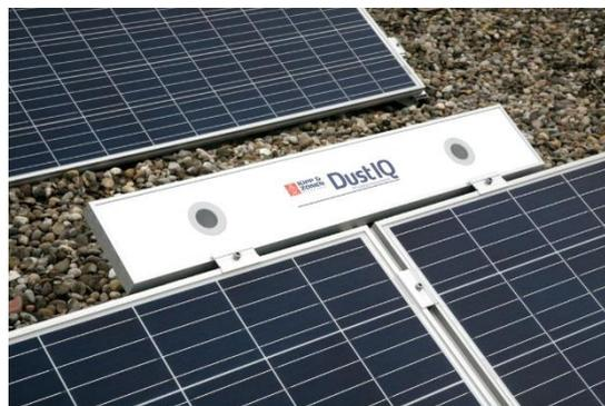
**Ilustración 27. Ejemplo de estación meteorológica e instalación DUSTIQ.**
