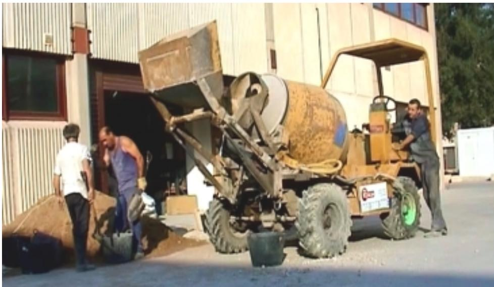
*Figura 24. Fabricación del hormigón de la primera fase de ensayos.*
