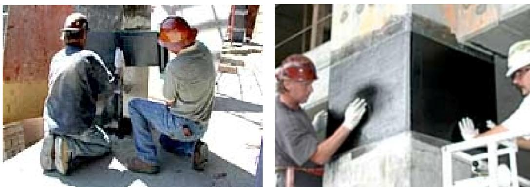
Fig. 4. Refuerzo con láminas de fibra de carbono ([www.sika.com](http://www.sika.com)).
