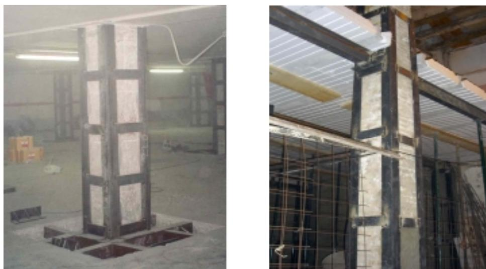
*Fig. 5. Refuerzo con angulares y presillas metálicas.*
