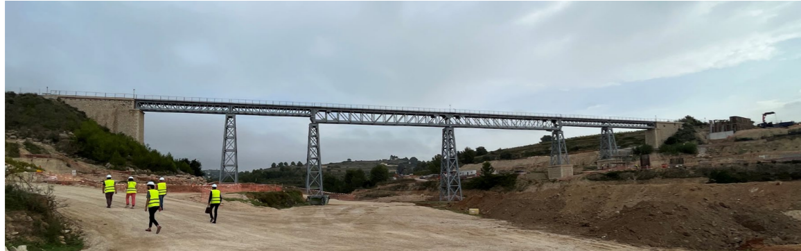
Figura 6. Vista general del puente del Barranco del Quisi. Fuente: Elaboración propia
