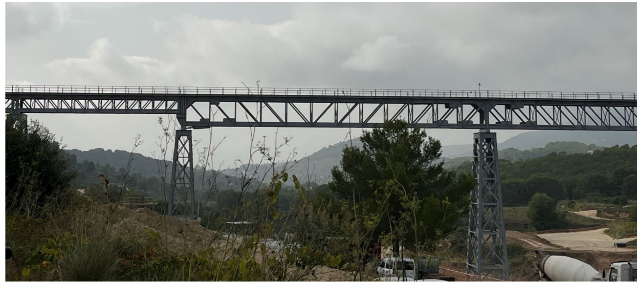
Figura 14. Vista del Viaducto del Quisi desde estribo este. Fuente: Elaboración propia
