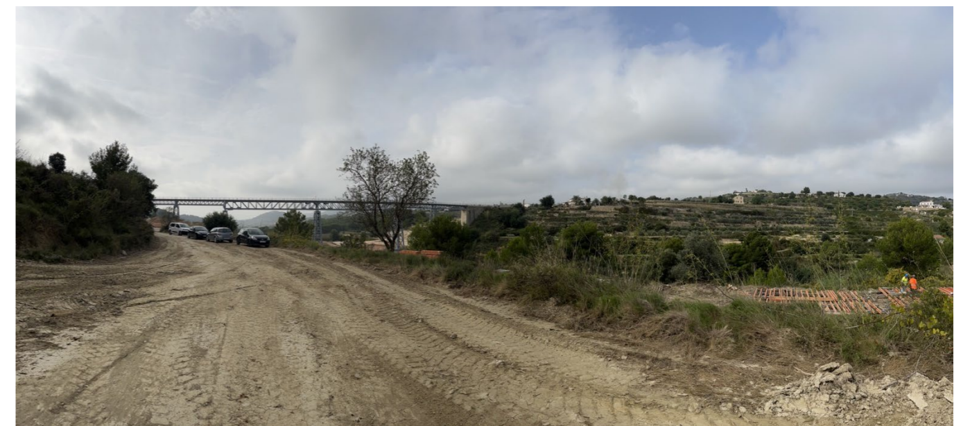
Figura 1. Visual desde aguas arriba del Puente del Quisi, ubicación aproximada de la pasarela. Fuente: Elaboración propia.
