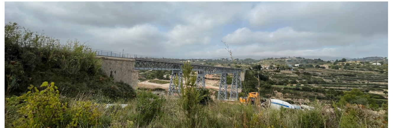
Figura 17 Vista desde la entrada de la zona de trabajos del puente (estribo este), desde aguas arriba. Fuente: Elaboración propia
