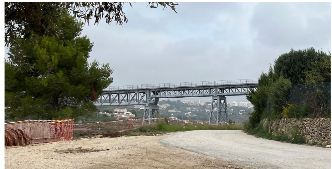
Figura 13. Vista del puente desde aguas abajo, estribo este(derecha). Fuente: Elaboración propia
