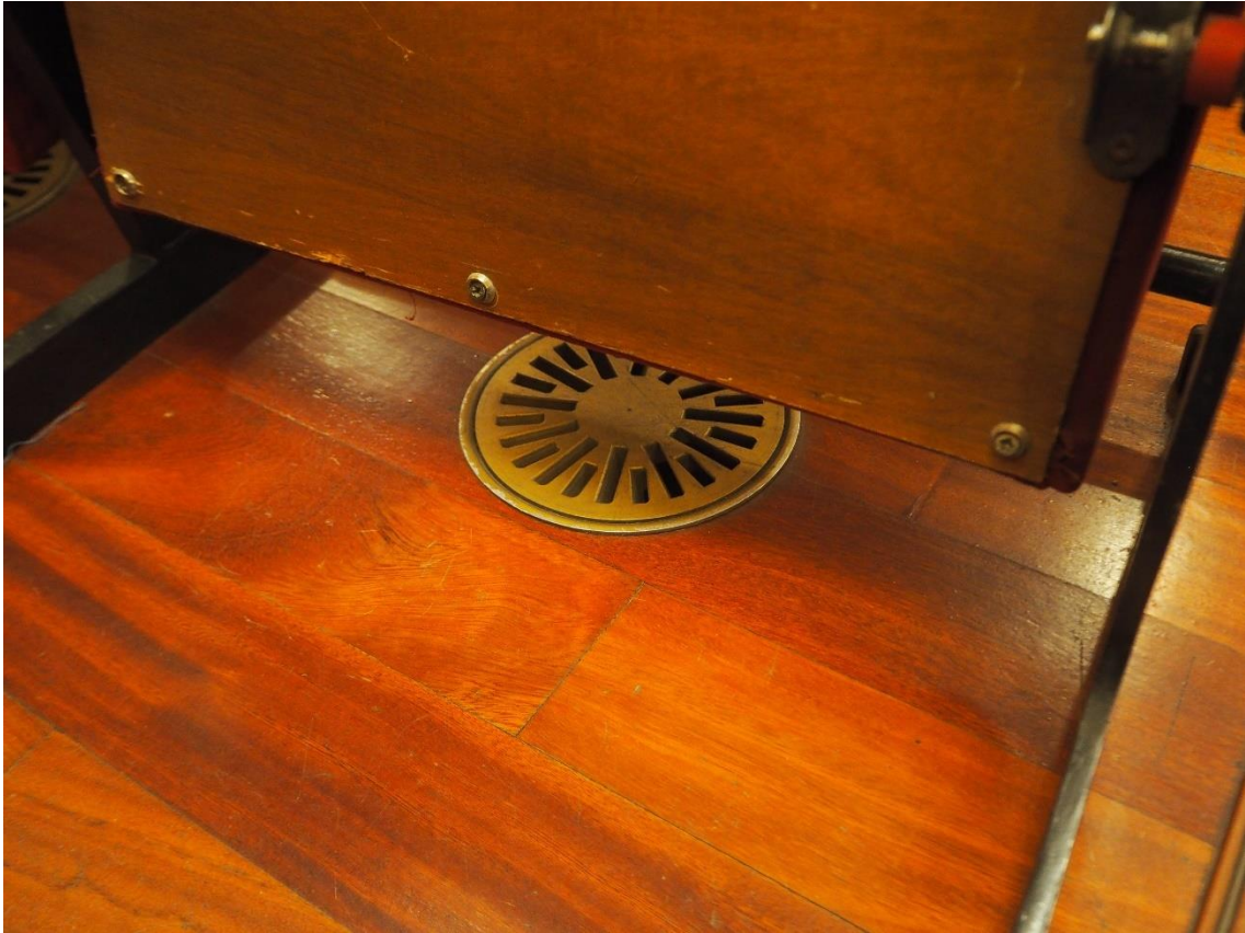
Figura 84. Instalaciones en el pavimento de platea
