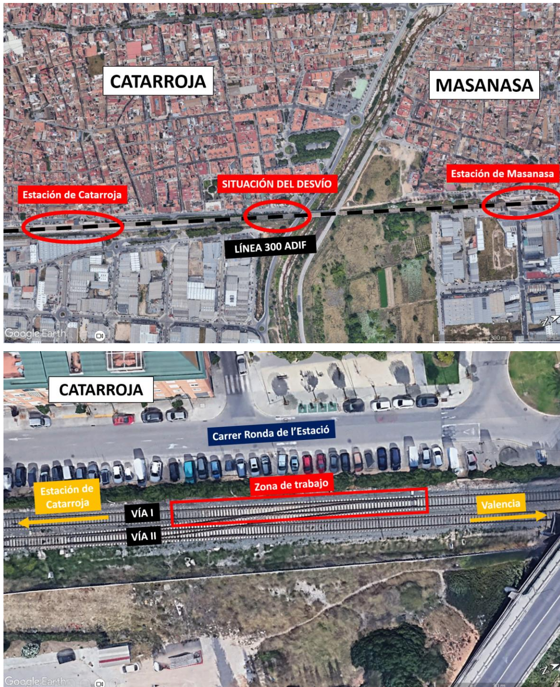
Figura 15. Superior: Situación general del desvío del que se han tomado los datos. Inferior: Zona de trabajo en la que se han realizado las mediciones. (Elaboración propia a partir de imágenes por satélite tomadas de Google Earth).
