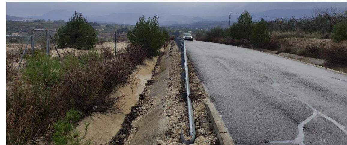
Figura 17 Cuneta de guarda en el margen derecho (dirección Alicante). Fuente: elaboración propia.
