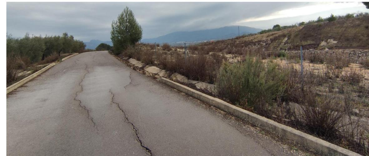
Figura 18 Cuneta de guarda en el margen derecho (dirección Valencia). Fuente: elaboración propia.
