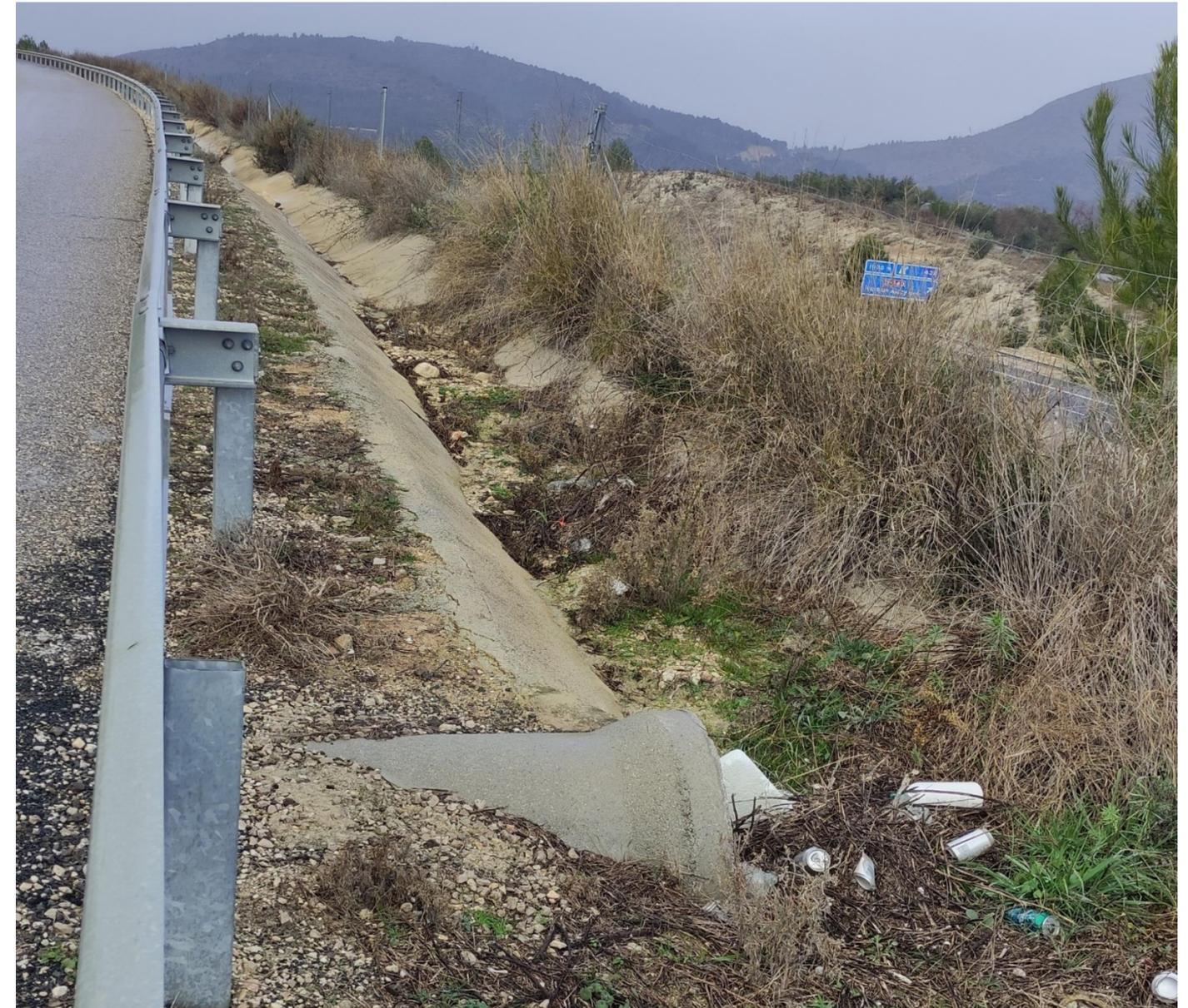
Figura 24 Estado del desagüe de la ODT de la cuneta de guarda. Fuente: elaboración propia.
