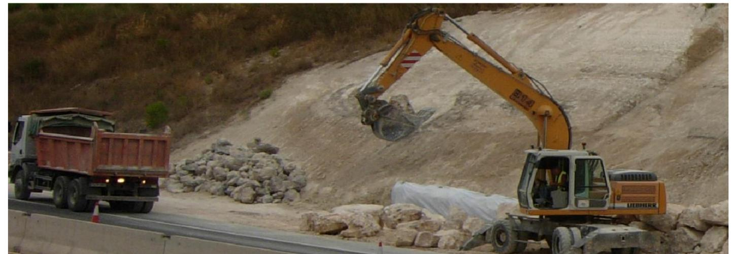
Figura 73 Almacenamiento y descarga de la escollera Fuente: Elaboración propia.
