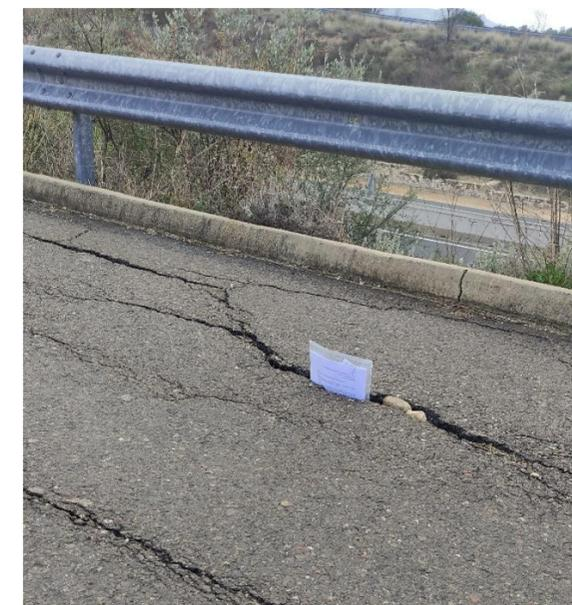
Figura 33 Profundidad de las grietas en el paquete de firmes. Fuente: elaboración propia
