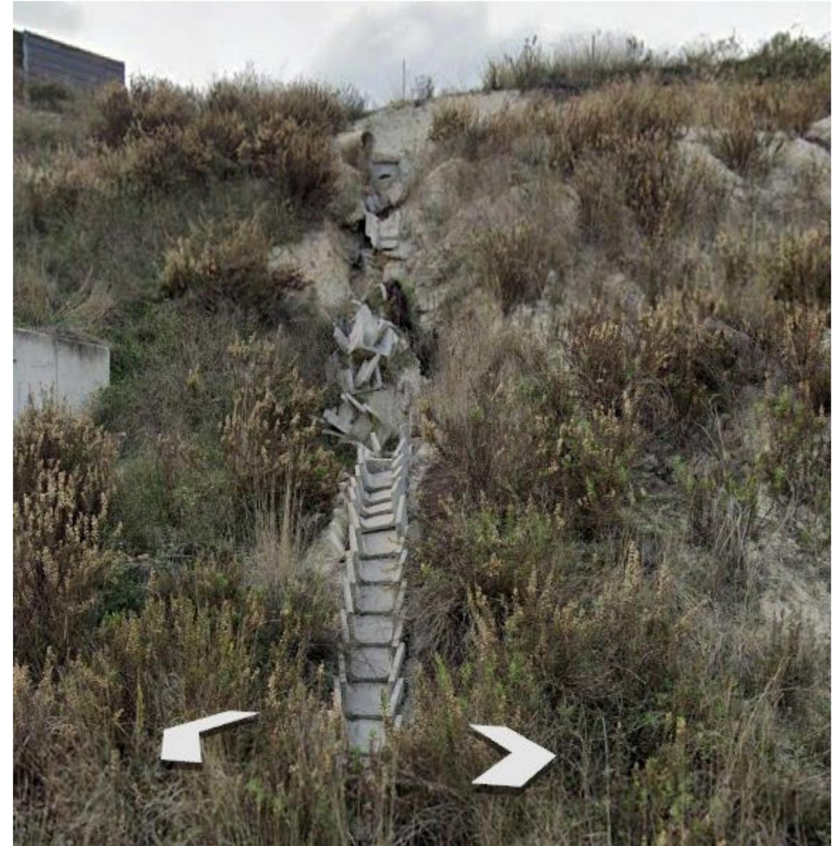
Figura 29 Estado de la bajante margen derecho dirección Valencia. Fuente: Google Earth.
