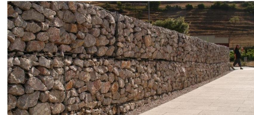
Figura 60 Muro de gaviones Fuente: <https://victoryepes.blogs.upv.es>.
