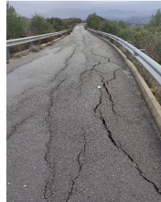
Figura 32 Estado actual de la vía de servicio por falta de mantenimiento. Fuente: elaboración propia
