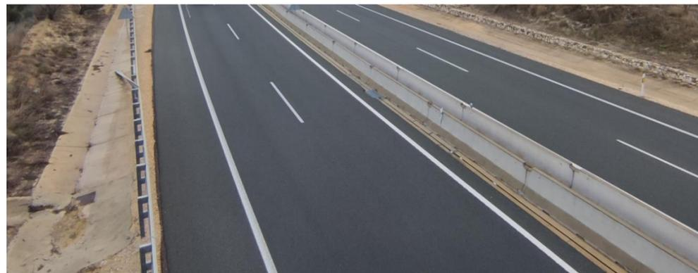
Figura 20 Cuneta de pie de desmonte revestida. Fuente: elaboración propia.
