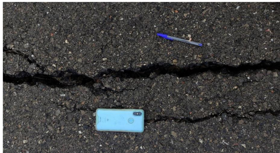
Figura 31 Estado actual de la capa de rodadura sin reparar. Fuente: elaboración propia
