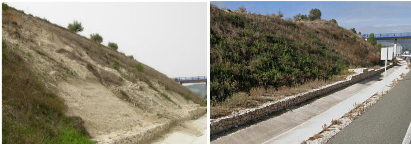
Figura 37 Antes y después del mantenimiento del P.K. 435+160 - 435+280 Fuente: Google Earth.
