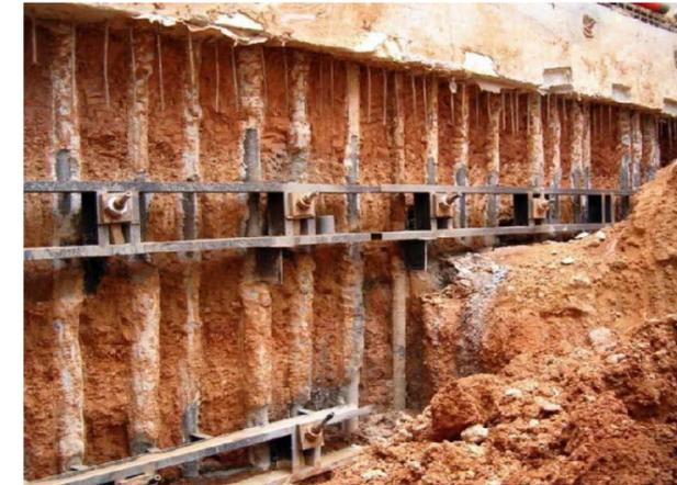
Figura 56 Construcción de un muro pantalla de micropilotes Fuente: <https://victoryepes.blogs.upv.es>.
