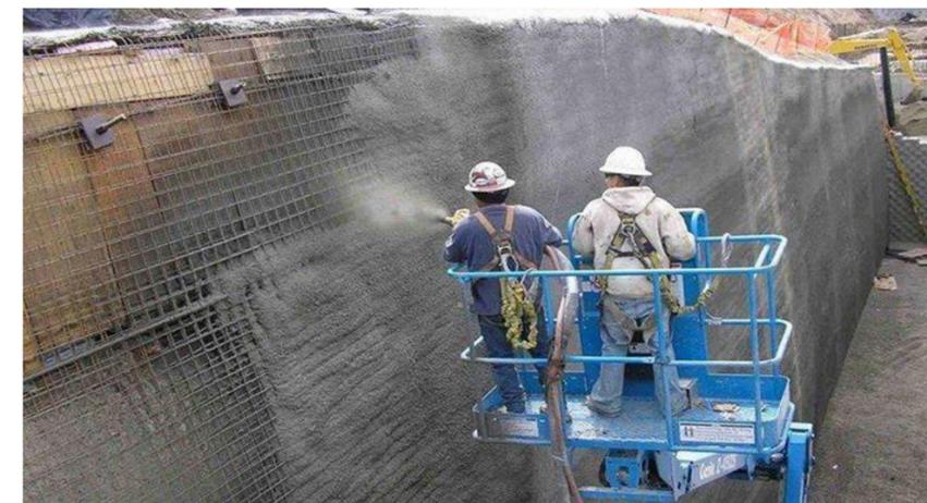
Figura 57 Proceso de revestimiento de la técnica Soil Nailing Fuente: Blog del Prof. <https://victoryepes.blogs.upv.es>.
