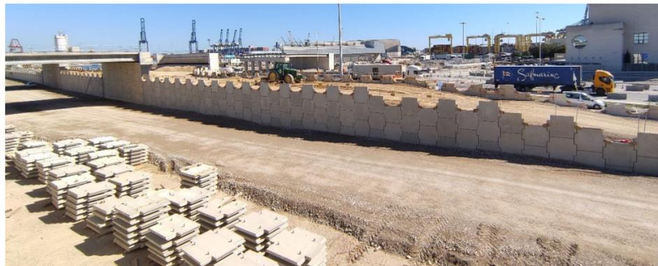
Figura 59 Construcción de muro de tierra armada Fuente: elaboración propia.
