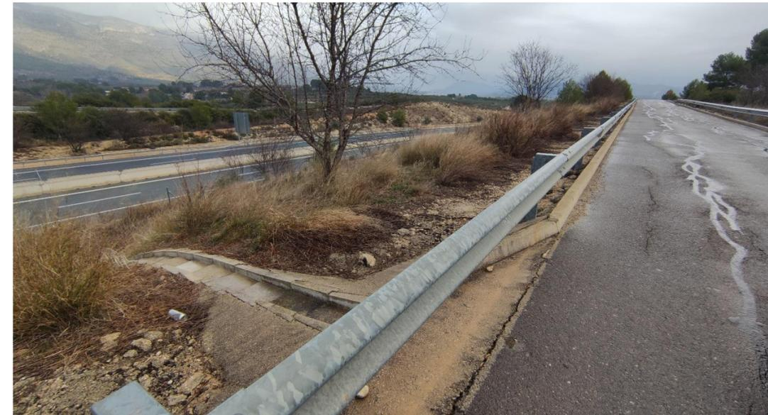
Figura 21 Obra de drenaje transversal (ODT). Fuente: elaboración propia.
