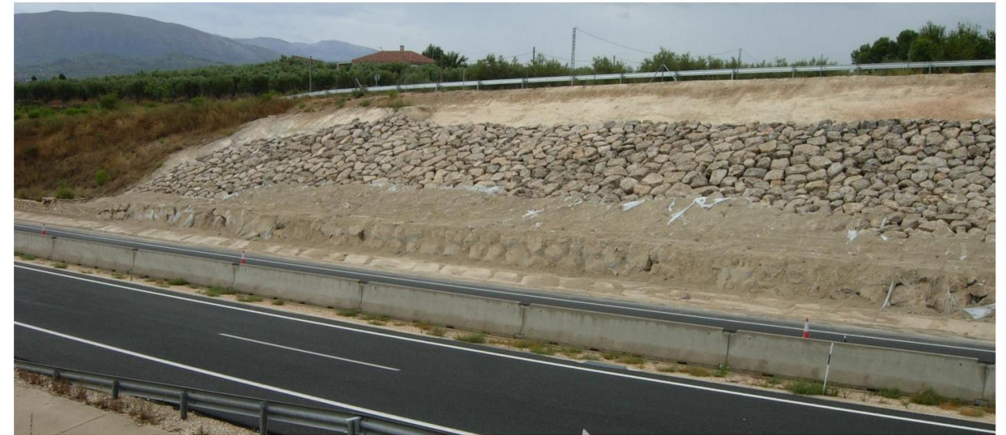
Figura 77 Finalización del manto de escollera con recebado en la parte inferior Fuente: Elaboración propia.
