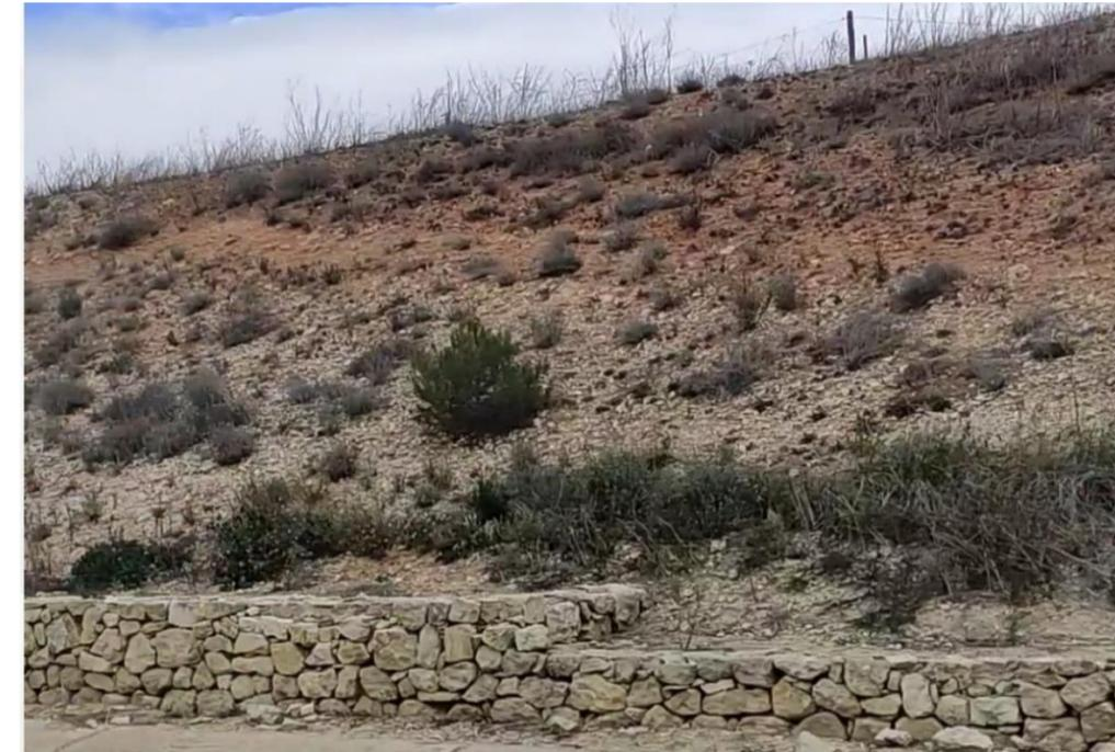
Figura 12. Talud de limos y arcillas. Fuente: elaboración propia.
