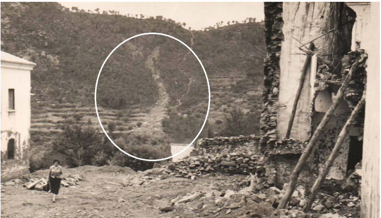
Figura 5. Canal abierto por el movimiento de masa de la ladera de El Quemado, situado al otro lado del cauce del Carraixet
