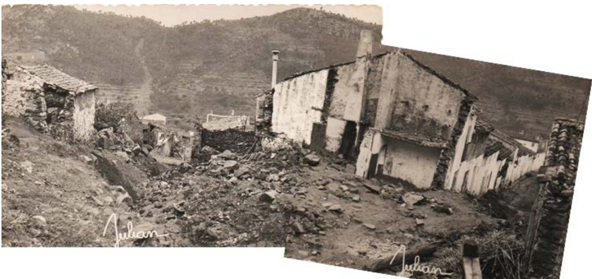
Figura 10. Composición a partir de dos fotografías [14 y 25 en Figura 2] que muestra la pared mediera de una de las dos viviendas derribadas por el flujo
