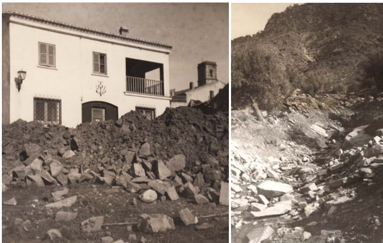
Figuras 14 y 15. A la izquierda (ADV) acumulación de derrubios frente a la Casa del Médico
