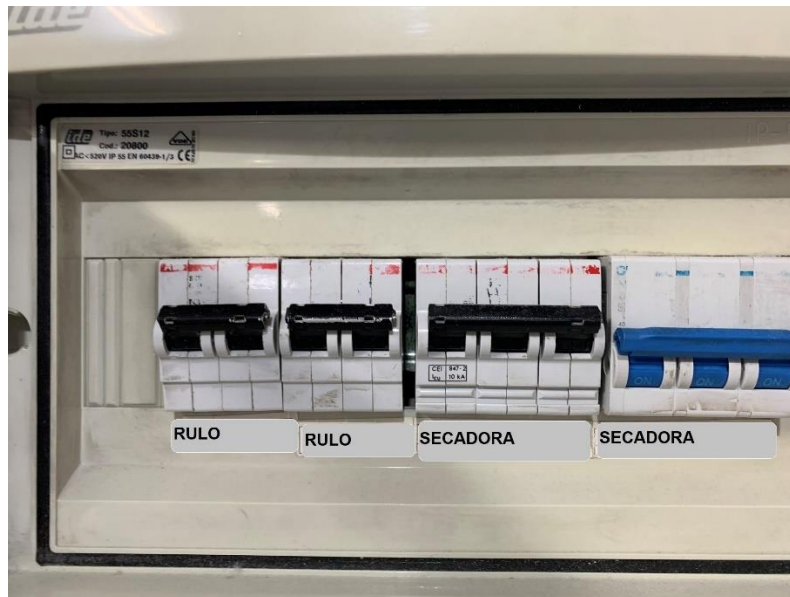
Figura 6: Cuadro secundario zona de secado
