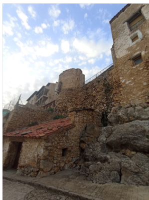
Figura 23. Muralla de Mosqueruela con torreón. Fuente: Elaboración propia (2023).
