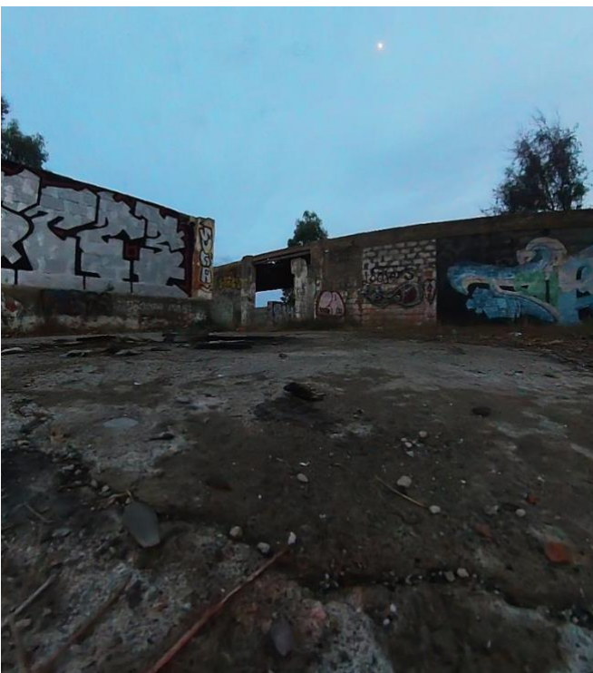
Fig. 37. Construcció de la Platja de Puçol.
