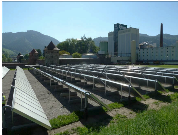
Figura 17: Colectores solares del proyecto “Solar Brew” en Leoben (Austria) [20].
