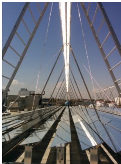
Figura 7. Concentradores Linear Fresnel en RAM Pharma, Jordania [24]
