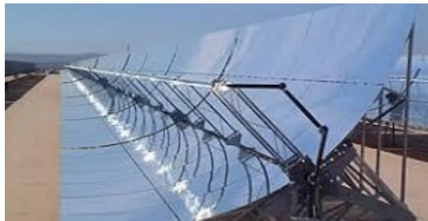
Figura 5. Colectores cilíndrico parabólicos [22]
