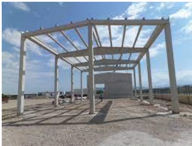
Imagen 1.1: Nave de hormigón
